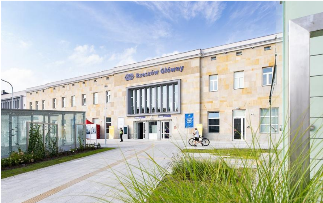
Fot. Widok na budynek dworca kolejowego w Rzeszowie (źródło: Polskie Koleje Państwowe S.A.)
