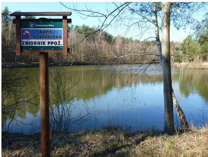
Zbiornik p.poż. – element infrastruktury przeciwpożarowego zabezpieczenia lasów. Leśnictwo Grabownica (fot. autor)
