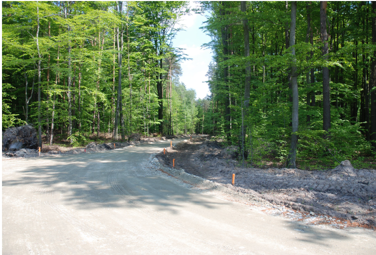
Budowa drogi / Leśnictwo Wal-kowo (fot. A. Ostaszewska - Nadl. Milicz).
