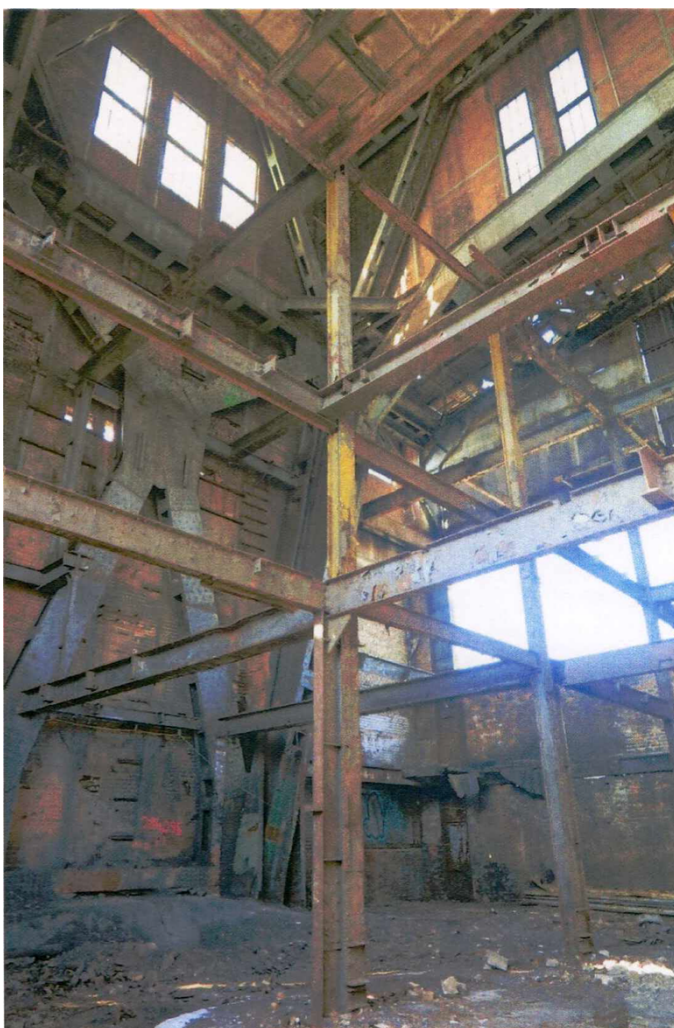
15. Wnętrze wieży z przyziemia - widoczna konstrukcja wsporcza dawnych stropów technicznych, w tle dolna część stalowej konstrukcji nośnej wieży oraz północnej ramy portalowej.
