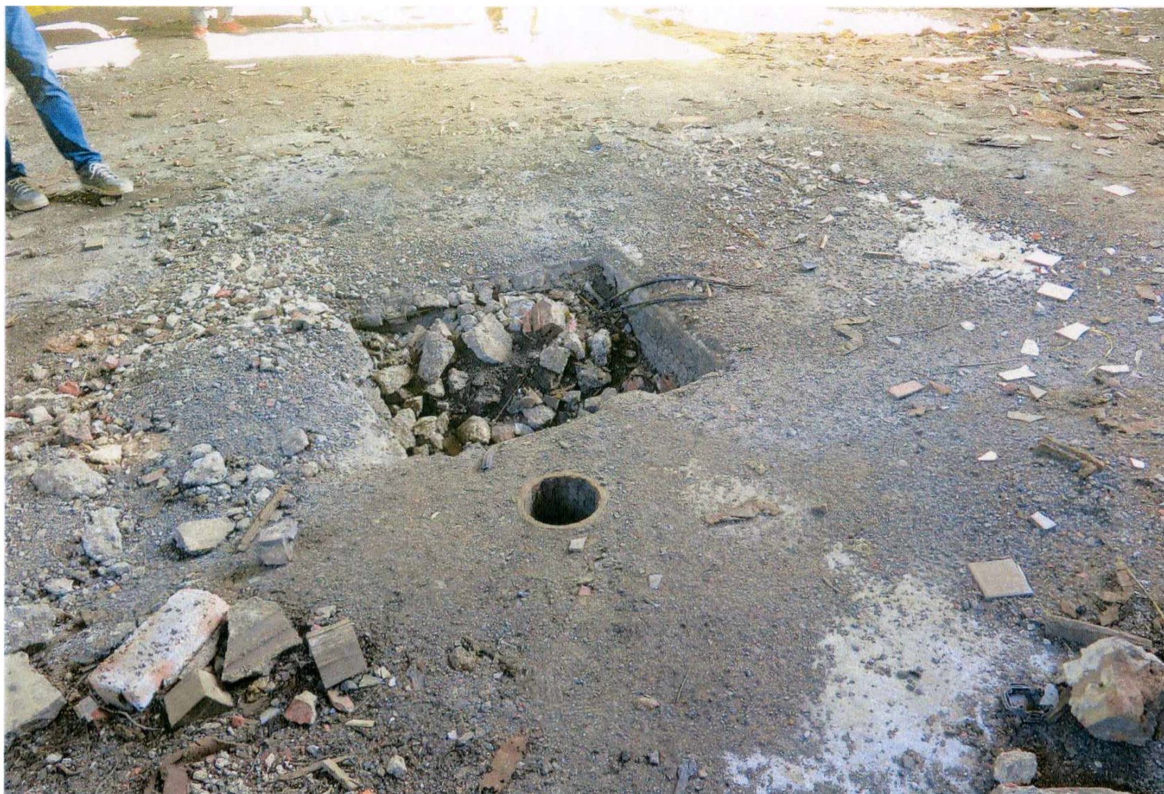
28. Wnętrze wieży - zagruzowana płyta żelbetowa zamykająca zasypany szyb, widoczny otwór do poziomu kontroli zasypu.
