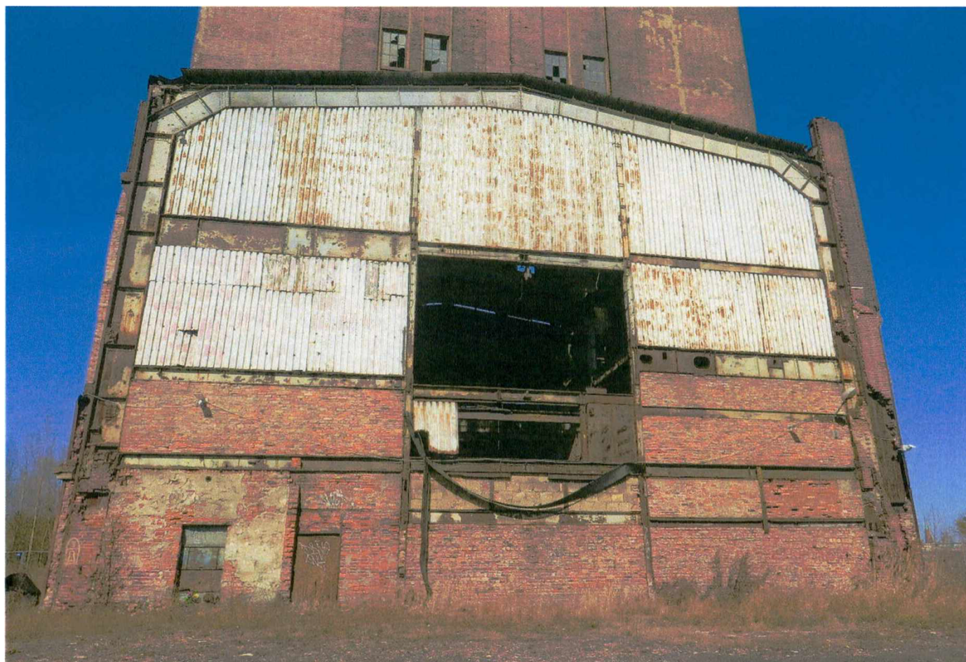
6. Stan zachowania południowej ściany osłonowej w konstrukcji stalowej w miejscu rozebranej hali nadszybia
