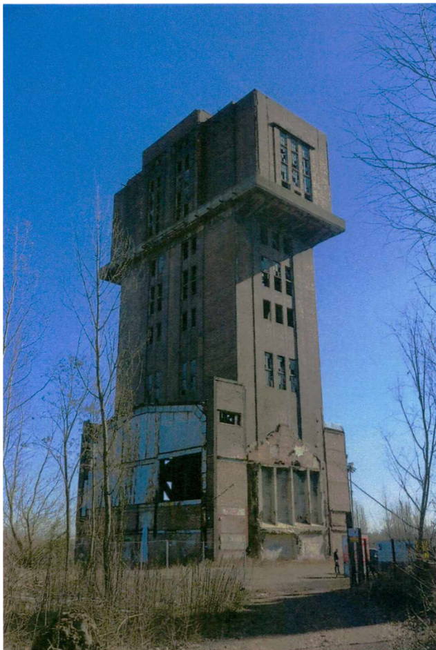
1. Wieża wyciągowa szybu Krystyna, widok od północnego zachodu zachodu.
