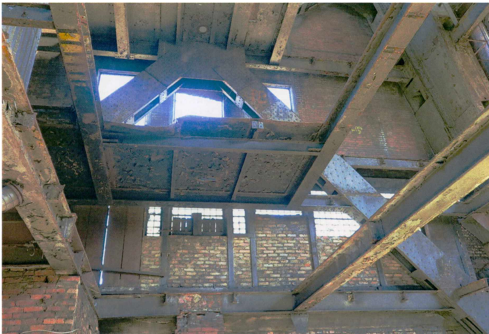
20. Wnętrze wieży w części wschodniej - widoczny fragment dolnej części konstrukcji nośnej wież oraz konstrukcja wsporcza stropów technicznych.
