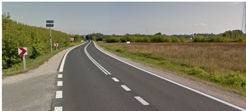
Droga krajowa jednojezdniowa pobocza nieutwardzone. Zastosowanie linii krawędziowych P-7a i P-7b(szerokich 24cm). Ze względu na numer szlaku międzynarodowego.
