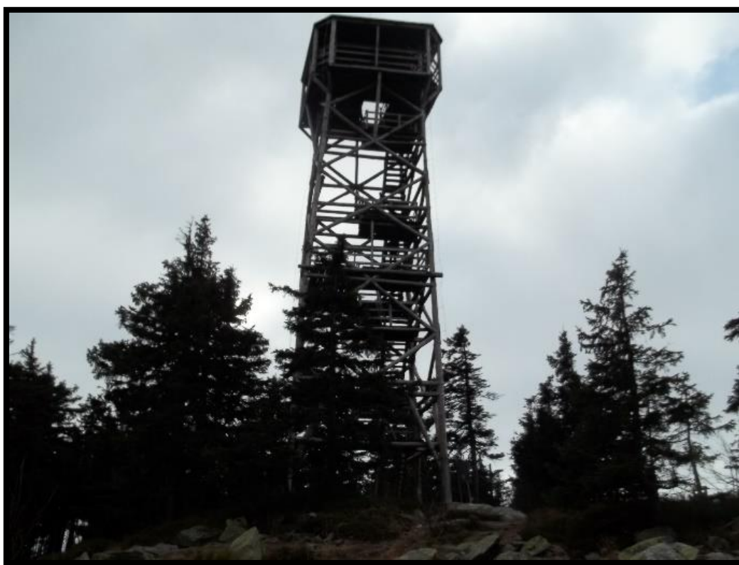
Zdjęcie 3. Wieża widokowa na Trójmorskim Wierchu (fot. M. Bryja)
