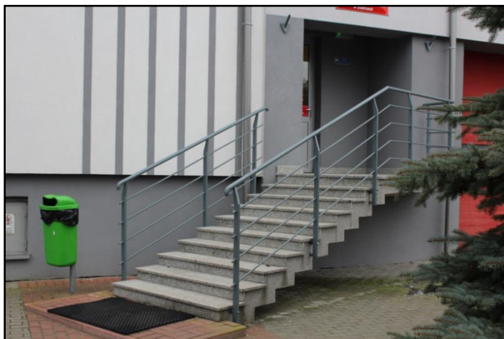
Fot. Wyremontowane schody.
