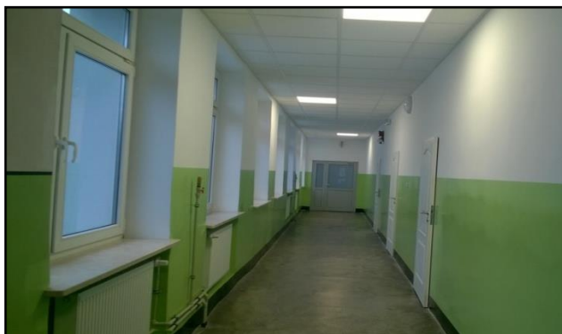
Fot. Remont korytarza.
