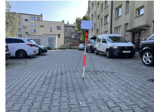
Szyb kat. A – widoczne ugięcie utwardzonej powierzchni w sąsiedztwie budynku wielorodzinnego na starym szybie Kinga I (ID 2.025) w Chorzowie
