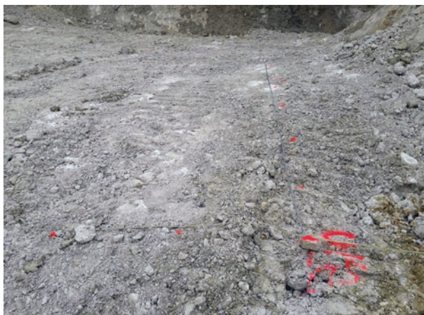
► Rys. 6. Przygotowanie terenu i wyznaczenie siatki do badań georadarem w systemie 3D nad pustkami wykrytymi w przodku V
