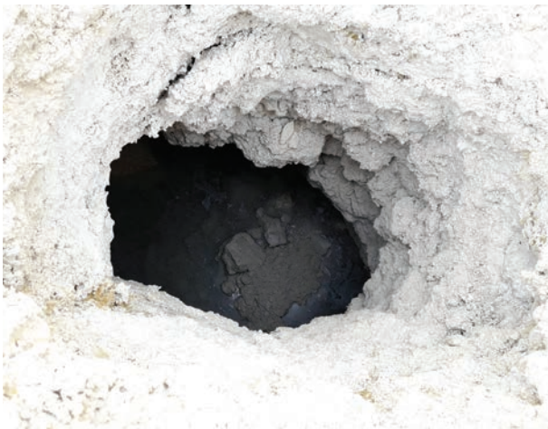
► Rys. 3. Pustka krasowa nawiercona podczas wykonywania robót strzałowych w przodku V
