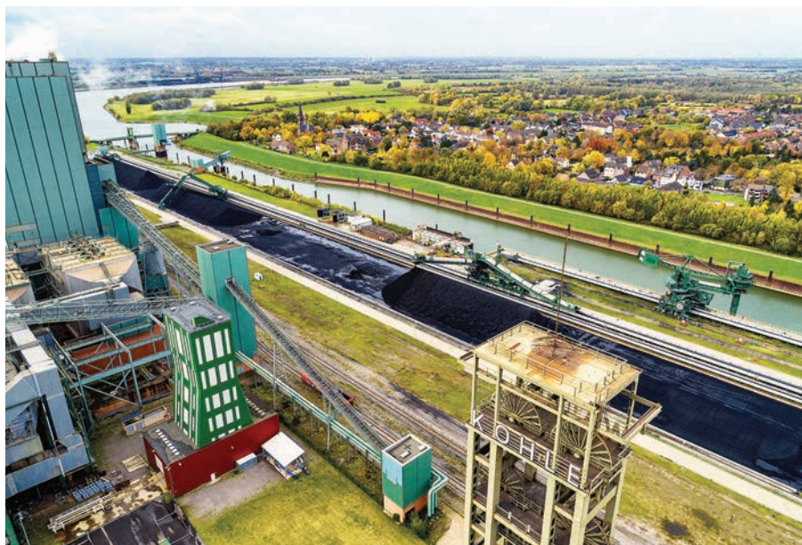
► Obiekt gospodarki wodnej Walsum. Do momentu zamknięcia z kopalni „Walsum” pompowano rocznie około 2,6 mln m 3 wody kopalnianej. W 2013 r. obiekt został przekształcony w zakład gospodarki wodą studzienną. Fot. RAG/Volker Wiciok
