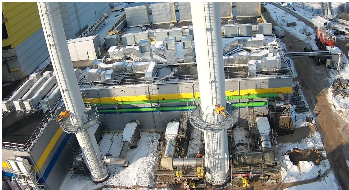
Plac budowy agregatów kogeneracyjnych w EC Gdynskiej
