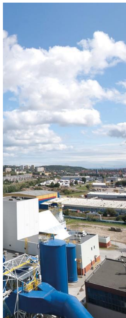
Instalacja odsiarczania spalin (IMOS) w EC Gdyńskiej
