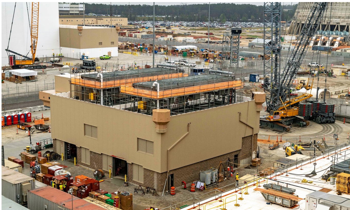
Rys. 3. Budynek zapasowych agregatów prądowłórczych bloku jądrowego Vogtle 4 podczas budowy w marcu 2022 r. (fot. Georgia Power Company).
