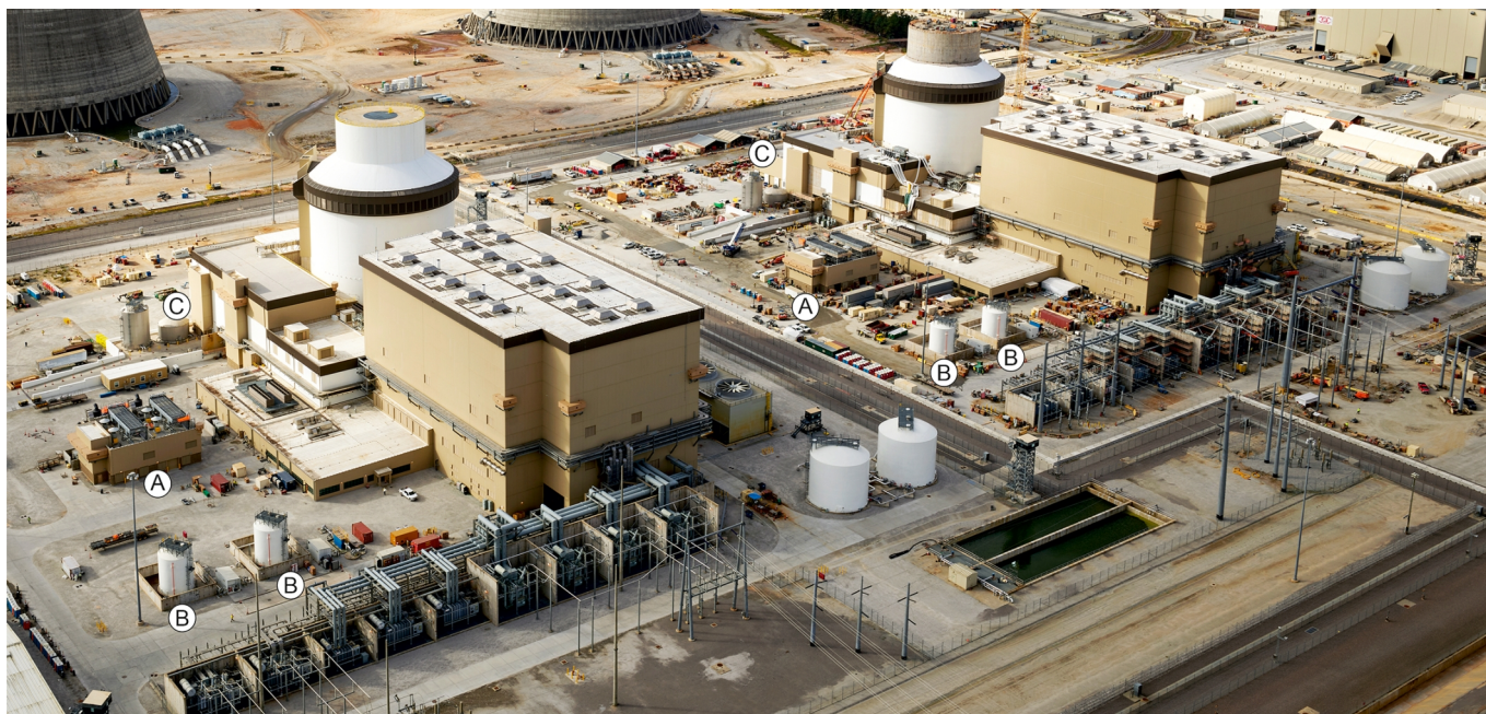
Rys. 5. Ogólny widok energetycznych bloków jądrowych nr 3 (z lewej) i 4 (z prawej) w elektrowni Alvin W. Vogtle Electric Generating Plant w Waynesboro w Georgii – najnowszych w energetyce amerykańskiej: A – budynki agregatów prądotwórczych – w każdym zainstalowane są dwie jednostki ESDG, każda o mocy 5,72 MW; B – główne zewnętrzne zbiorniki paliwa do agregatów – każdy o pojemności 227 100 dm 3 , C – miejsce zainstalowania mniejszych agregatów ADGU – w każdym bloku 2 jednostki, każda o mocy 80 kW (fot. Georgia Power Company, odnośniki autora).
