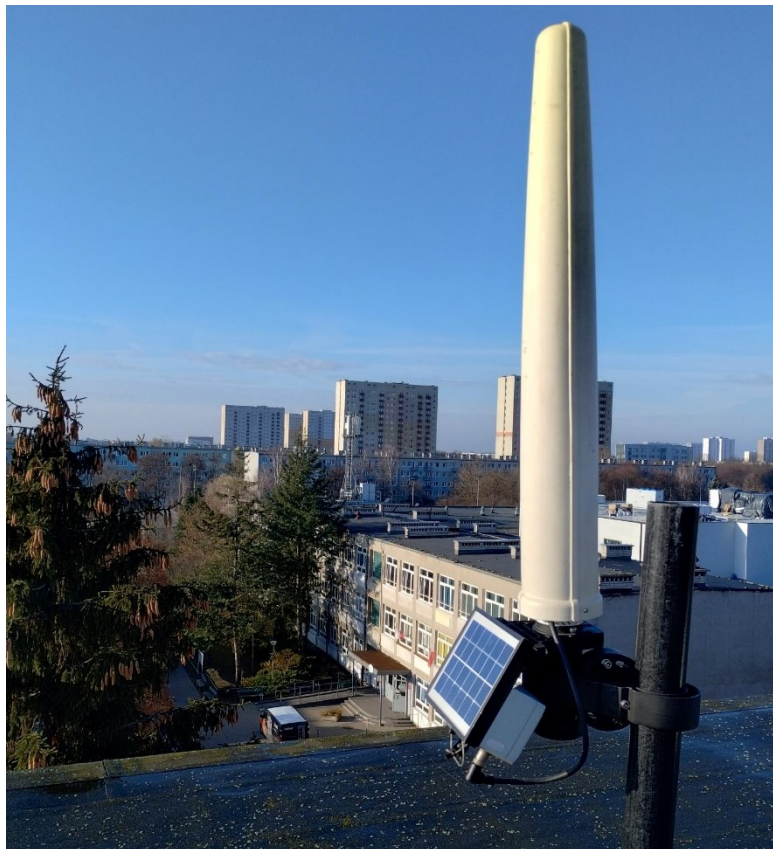
Rys. 2 Miejsce montażu SMS PEM – Wichrowe Wzgórze 10 – widok na SBTK
