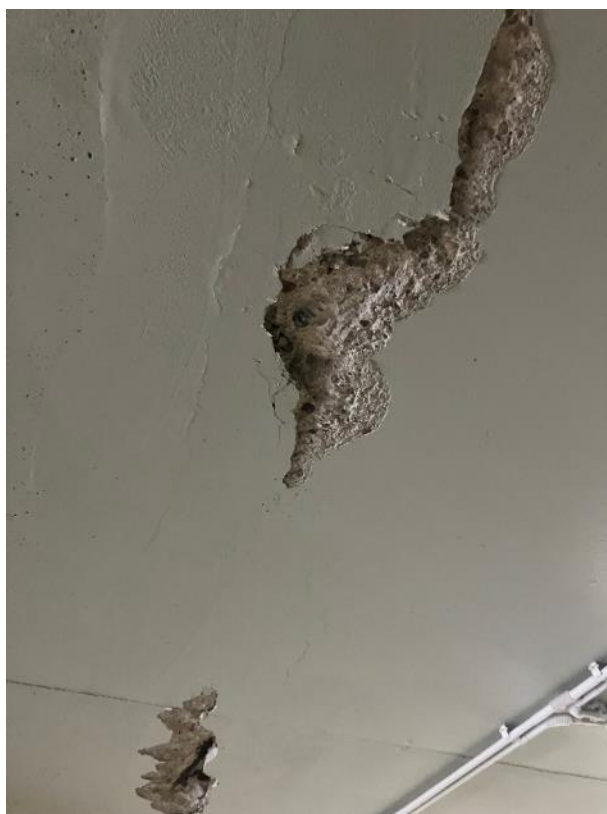
Fot. 9. Zniszczona w wyniku przecieku otulina zbrojenia i odsłonięte pręty zbrojeniowe.
