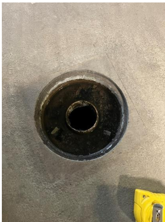
Fot. 10, 11. Wpusty odwodnieniowe (zdjęcie z góry)
