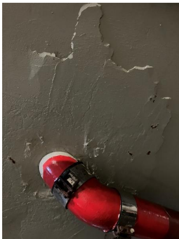
Fot. 3, 4. Łuszczenie się powłok malarskich stropu wokół wpustów odwodnieniowych.
