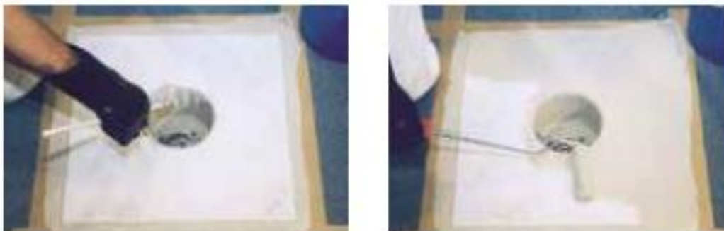
Rys. 8, 9. Schemat wykonywania uszczelnienia
