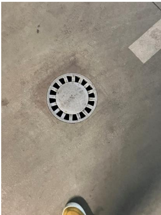
Fot. 10, 11. Wpusty odwodnieniowe (zdjęcie z góry)
