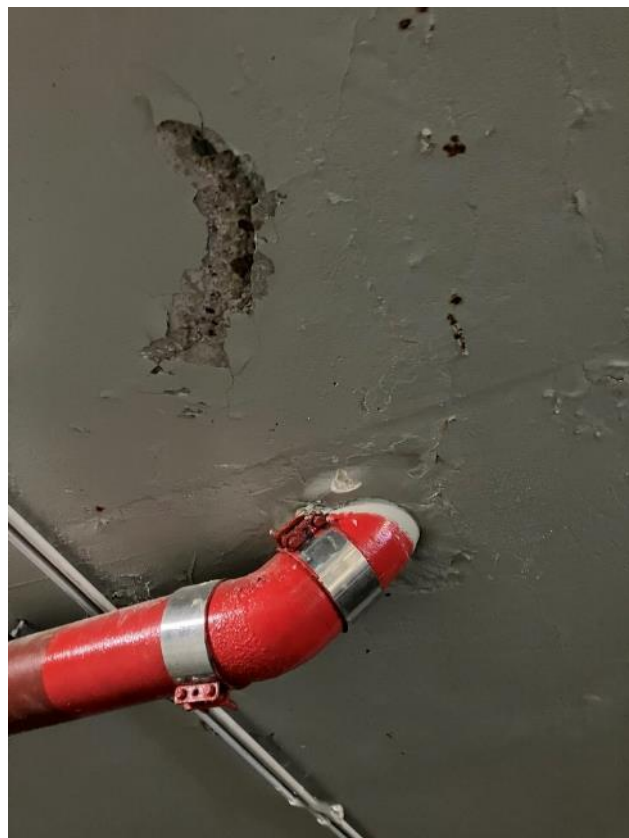
Fot. 7, 8. Łuszczenie się oraz ubytki powłok malarskich stropu, miejscowe ubytki otuliny betonowej zbrojenia wokół wpustów odwodnieniowych.
