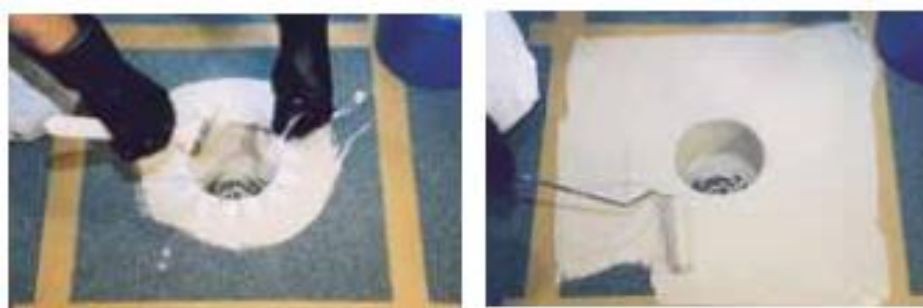
Rys. 6, 7. Schemat nakładania warstw żywicy
