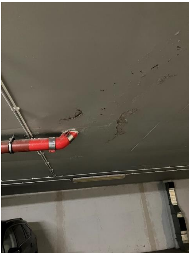
Fot. 7, 8. Łuszczenie się oraz ubytki powłok malarskich stropu, miejscowe ubytki otuliny betonowej zbrojenia wokół wpustów odwodnieniowych.
