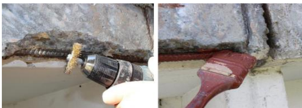
Rys. 1, 2. Czyszczenie i zabezpieczenie antykorozyjne stali zbrojącej
