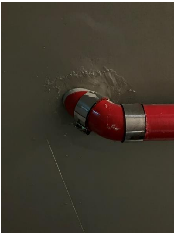
Fot. 3, 4. Łuszczenie się powłok malarskich stropu wokół wpustów odwodnieniowych.
