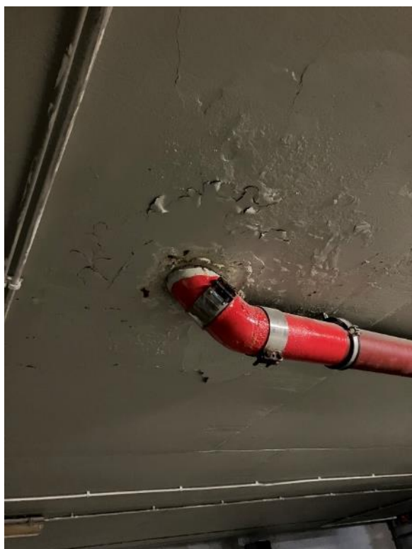
Fot. 3, 4. Łuszczenie się powłok malarskich stropu wokół wpustów odwodnieniowych.
