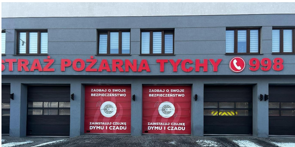
Rys. 22 Oklejenie bram garażowych od strony al. Niepodległości.
