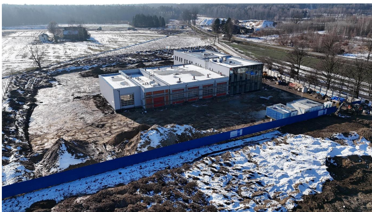
Rys. 26 Widok na budowę Jednostki Ratowniczo-Gaśniczej w Bieruniu.
