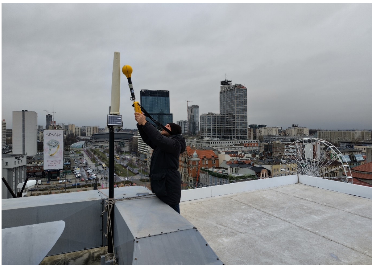
Rys. 4 Miejsce montażu SMS PEM – Rynek 1– widok na SBTk
