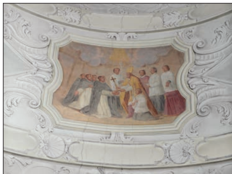
30. Polichromia sklepienia kaplicy Paryskiej przed pracami, fot. M. Filip, 2013.
