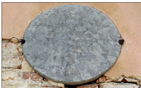
52. Włodawa, kaplica grobowa Katarzyny z Osypowiczów Seredynowej, tablica inskrypcyjna przed rozpoczęciem prac, fot. P. Wira, 2017 r.
