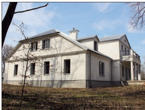
53. Wilczyśka, dwór, elewacja ogrodowa, fot. J. Maraśkiewicz.
