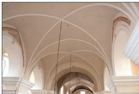
4. Sklepienie nawy głównej, fot. B. Stolarz, 2018.
