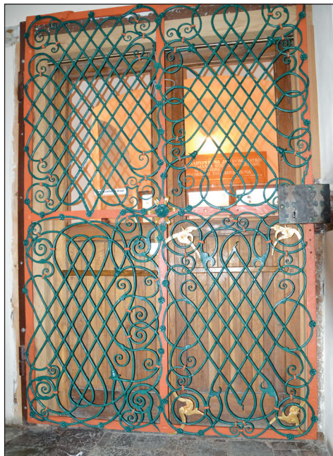
25. Lublin, kościół św. Ducha, krata wejścia bocznego po pracach, fot. K. Tur-Marciszek 2017 r.
