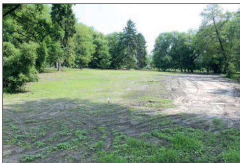
20. Park pałacowy w Międzyrzecu Podlaskim w trakcie prac rewaloryzacyjnych, dawny salon parkowy, fot. J. Maraśkiewicz, 2017
