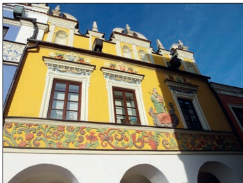
64. Zamość, kamienica Pod Madonną, elewacja frontowa, stan po pracach, fot. M. Filip, 2017 r.
