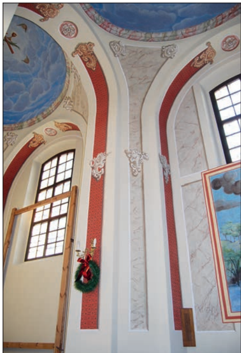
47. Tarnogród, kościół pw. Przemienienia Pańskiego, nawa południowa, fragment polichromii, stan po pracach, fot. M. Filip, 2017 r.
