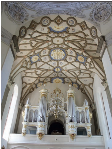
23. Kodeń, kościół pw. św. Anny, sklepienie nawy gł., fot. J. Maraśkiewicz.
