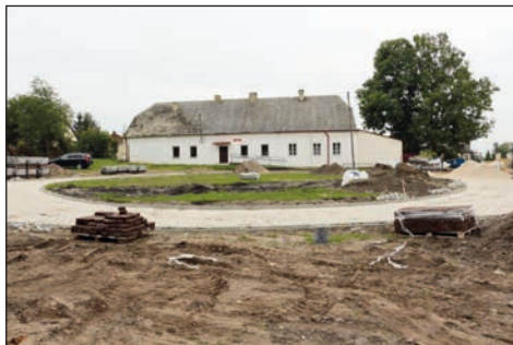
3. Park w zespole pałacowo-parkowym w Rejowcu w czasie prac restauracyjnych, budowa układu drogowego, fot. M. Wilk, 2017.
