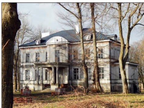
8. Chylin Wielki, prace przy elewacjach dworu, fot. Del. w Chełmie, 2017.
