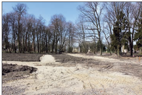
24. Park pałacowy w Międzyrzecu Podlaskim w trakcie prac rewaloryzacyjnych, wytyczenie kwater, fot. J. Maraśkiewicz, 2017
