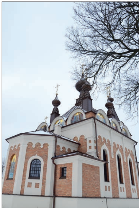
8. Sławatycze, cerkiew, elewacje po remoncie, fot. A. Frąckiewicz, 2018.
