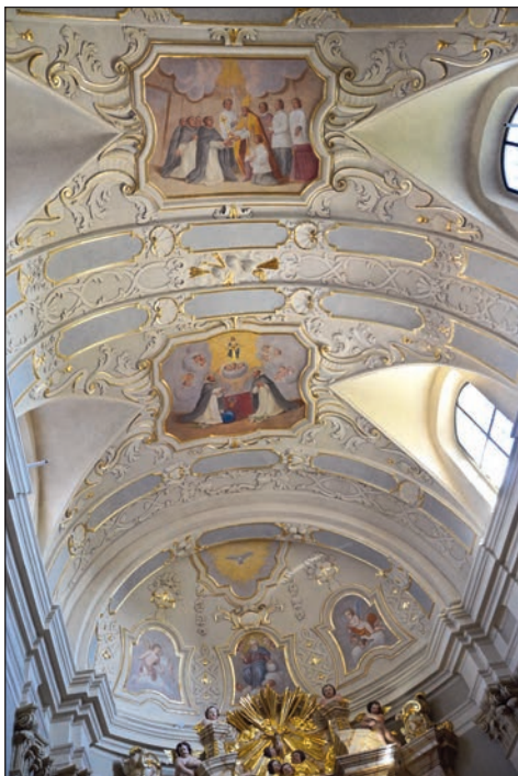
32. Sklepienie kaplicy paryskiej po pracach, fot. K. Tur-Marciszek, 2017.
