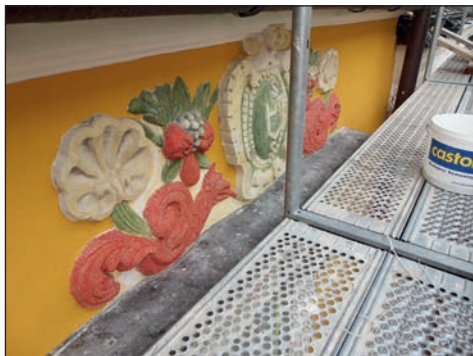
63. Zamość, kamienica Pod Madonną, elewacja frontowa, fragment dekoracji, stan w trakcie prac, fot. M. Filip, 2017 r.
