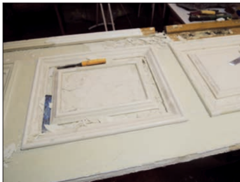
6. Udrycze, dwór, konserwacja drzwi wewnętrznych, fot. Del. w Zamościu.
