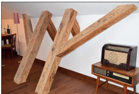
9. Udrycze, dwór, fragm. poddasza po adaptacji, fot. A. Frąckiewicz, 2018.
