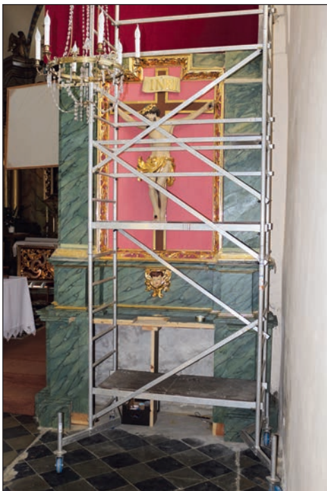
11. Gorzków, kościół rzymskokatolicki pw. św. Stanisława BM, ołtarz boczny pw. Ukrzyżowania w trakcie prac, fot. P. Wira, 2017 r.
