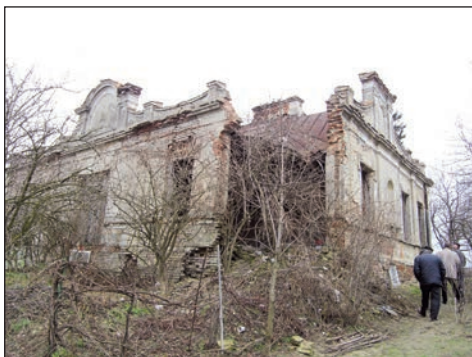
1. Dys, dwór Bernatówk, stan przed remontem, fot. od właściciela.
