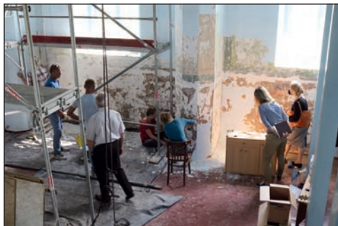
51. Uhrusk, cerkiew prawosławna pw. Zaśnięcia NMP, polichromie ścienne w trakcie prac, fot. P. Wira, 2017 r.
