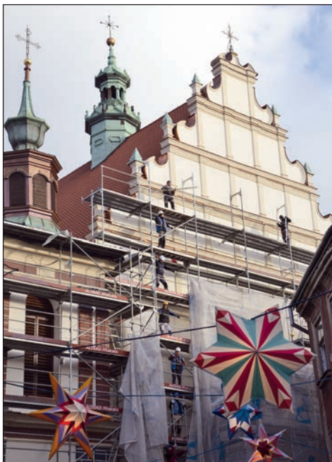
40. Lublin, ul. Złota 9, kościół dominikanów w trakcie remontu, for. K. Rutkowski, 2017.
