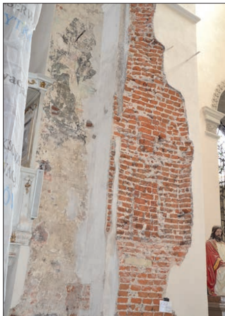
11. Ściana przytęczowa południowa z dekoracją malarską, fot. B. Stolarz, 2017.
