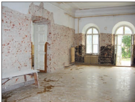
5. Udrycze, dwór, wnętrze w trakcie prac, fot. Del. w Zamościu, 2013.
