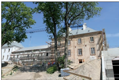
7. Janów Podlaski, oficyna zach. w trakcie remontu, fot. Del. w Białej Podl.
