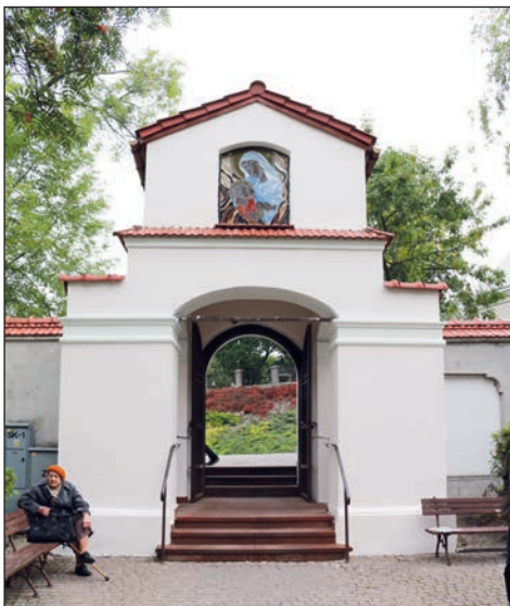
6. Chełm, dzwonnica-brama po remoncie, fot. Del. w Chełmie, 2017.
