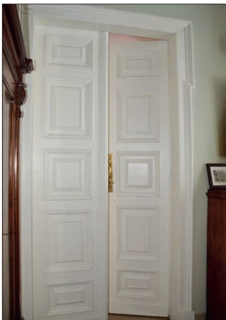
13. Udrycze, dwór, stolarka drzwiowa po konserwacji, fot. A. Frąckiewicz, 2018.
