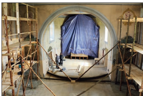
7. Buśno, kościół rzymskokatolicki pw. Wniebowzięcia NMP, polichromia ścienna w trakcie prac, fot. P. Wira, 2017 r.
