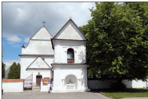
17. Klesztów, dzwonnica przed remontem, fot. Del. Chełm, 2017.
