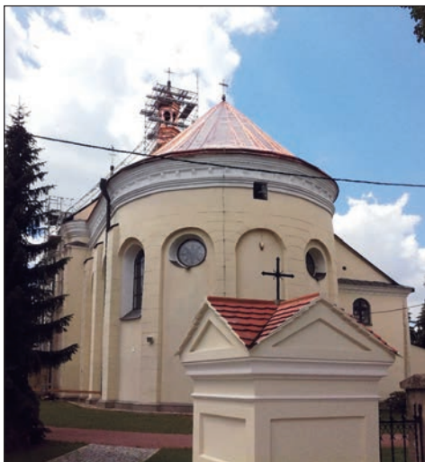
1. Bełżyce, kościół parafialny, wymiana pokrycia dachu, fot. K. Zarzycka-Goliszek, 2017.
