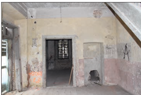
12. Janów Podlaski, oficyna wsch., d. przedpokój, stan przed remontem.
