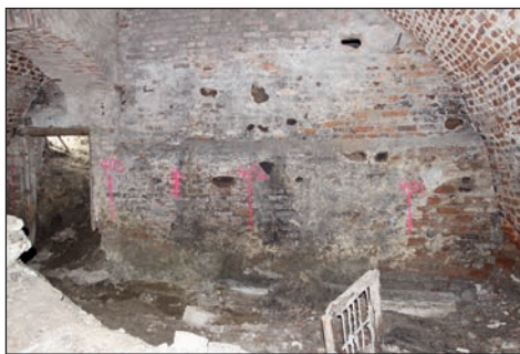
8. Janów Podlaski, oficyna wsch., piwnice przed remontem
