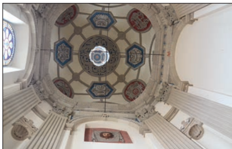
15. Kaplica Firlejów po pracach, fot. B. Stolarz, 2018.
