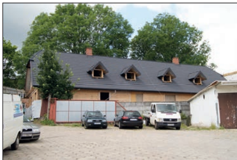
25. Kraśnik, ul. Narutowicza 29, d. szpital przykościelny, stan w trakcie odbudowy, fot. M. Kurczewicz, 2017.
