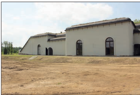
21. Kobylany, Koszary odcinkowe, fragm. elewacji frontowej, fot. J. Maraśkiewicz.
