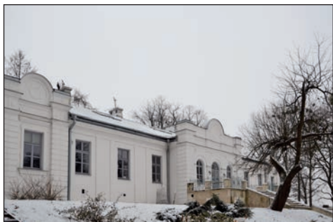
8. Udrycze, dwór po remoncie, elewacja ogrodowa, fot. A. Frąckiewicz, 2018.
