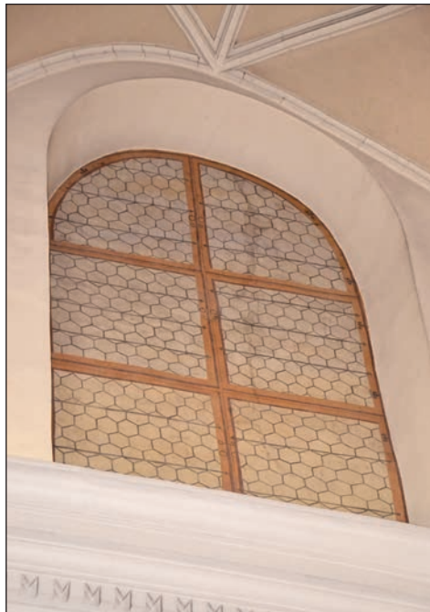
3. Malowane okno prezbiterium, fot. B. Stolarz, 2017.
