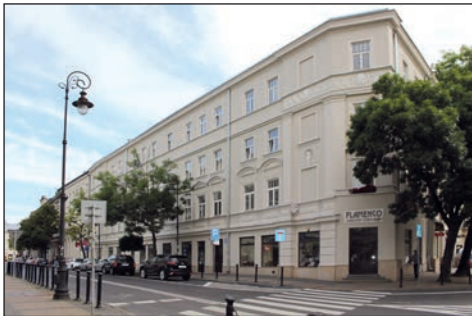
33. Lublin, ul. Kapucyńska 6, stan kamienicy po remoncie, fot. K. Rutkowski, 2017.
