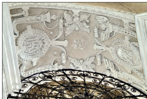
14. Podłączenie arkady przejścia do kaplicy Firlejów przed pracami, fot. P. Maciuk, 2006.
