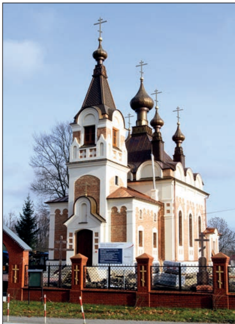
5. Ślawatycze, cerkiew, w trakcie remontu, fot. Del. Biała Podl., 2016
