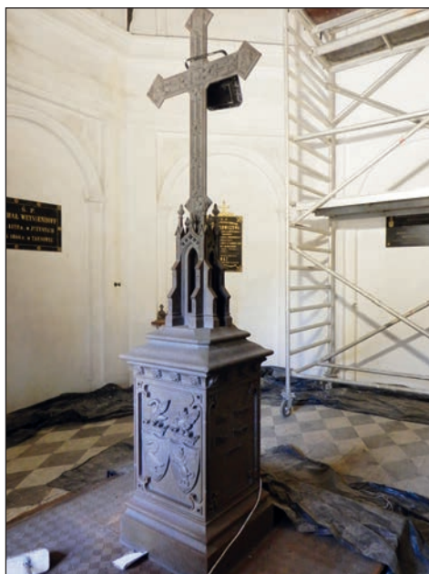
16. Kamionka, wnętrze kaplicy Weyssenhoffów w trakcie prac, fot. A. Wiśniewska, 2017.
