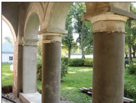
4. Udrycze, dwór, fragm. portyku w trakcie prac, fot. Del. w Zamościu, 2012.
