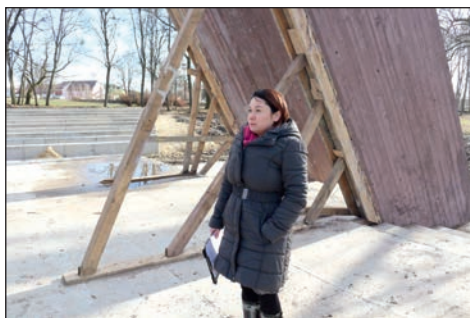
4. Park w zespole pałacowo-parkowym w Rejowcu w czasie prac restauracyjnych, budowa elementów „małej architektury” – amfiteatru ogrodowego, fot. M. Wilk, 2017.
