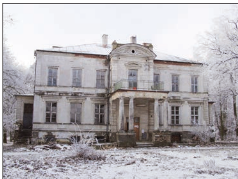
7. Chylin Wielki, dwór przed remontem, fot. Del. w Chełmie, 2017.
