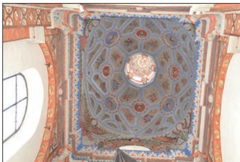
44. Lublin, ul. Złota 9, kopuła kaplicy Ossolińskiej po pracach, fot. P. Maciuk.
