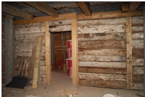
28. Kraśnik, ul. Narutowicza 29, d. szpital przykościelny, stan w trakcie odbudowy – ścianki działowe z oryginalnych belek, fot. M. Kurczewicz, 2017.
