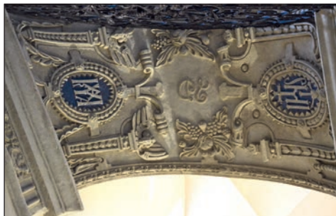
21. Dekoracja podłucza arkady przejścia do kaplicy Firlejów po pracach, fot. B. Stolarz, 2018.
