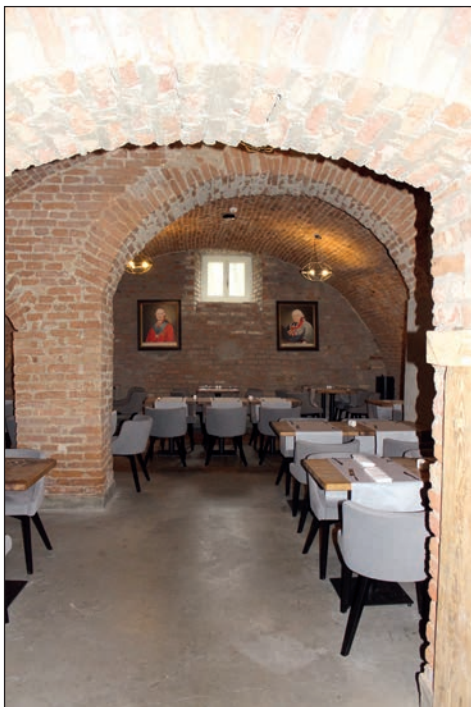
11. Janów Podlaski, oficyna wsch., piwnice po remoncie i adaptacji, fot. A. Frąckiewicz, 2018.
