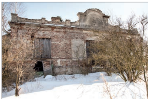
2. Dys, dwór Bernatówka, elewacja przed remontem, fot. od właściciela.
