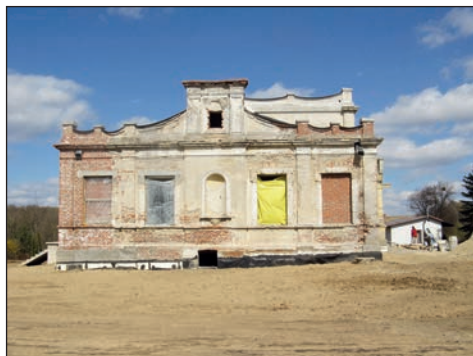
7. Dys, dwór Bernatówka, w trakcie prac re-montowych, fot. od właściciela.
