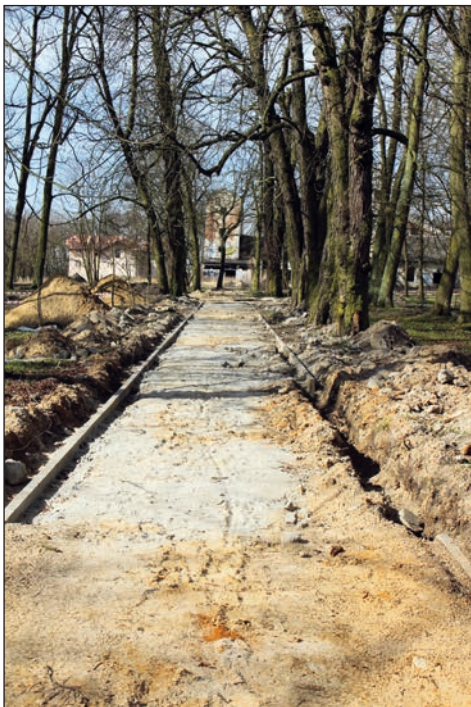
22. Park pałacowy w Międzyrzecu Podlaskim w trakcie prac rewaloryzacyjnych, wytyczanie alei, fot. J. Maraśkiewicz, 2017
