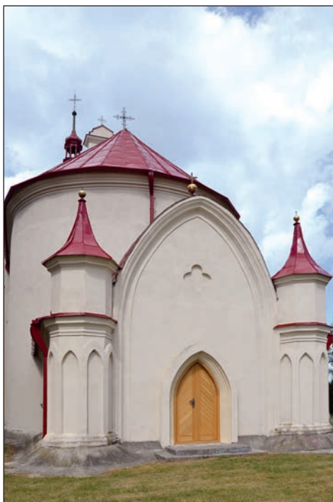
50. Rybitwy, kościół pw. Wszystkich Świętych, elewacja z wymienioną stolarką drewnianą, fot. B. Stolarz, 2017.
