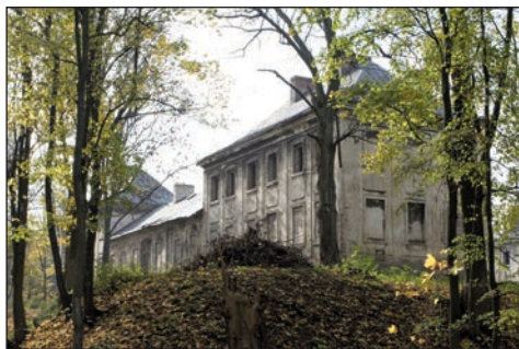
4. Janów Podlaski, oficyna wsch., przed remontem, fot. Del. w Białej Podl.
