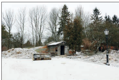
11. Park w zespole szpitala wojskowego w Chełmie w czasie prac adaptacyjnych na cele Państwowej Szkoły Muzycznej w Chełmie, piwniczka ogrodowa w czasie remontu muru oporowego, fot. M. Wilk, 2017.
