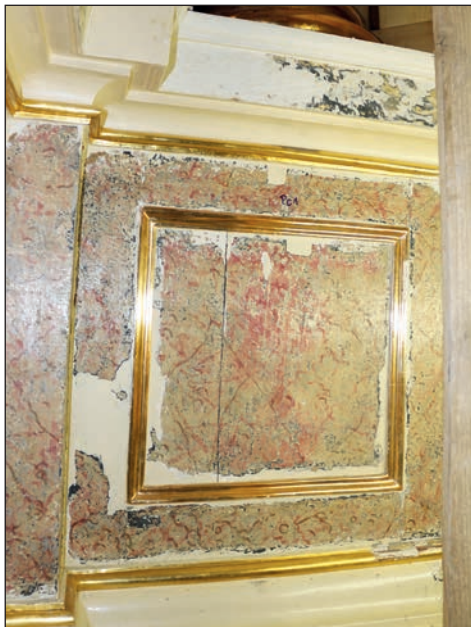
17. Krasnystaw, kościół rzymskokatolicki pw. św. Franciszka Ksawerego, ołtarz główny w trakcie prac, fot. P. Wira, 2017 r.
