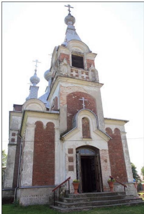
3. Ślawatycze – cerkiew przed remontem, fasada, fot. Del. Biała Podlaska, 2014.
