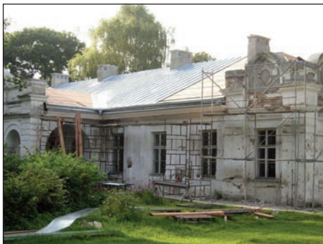
3. Udrycze, dwór w trakcie remontu, fot. Del. w Zamościu, 2010.
