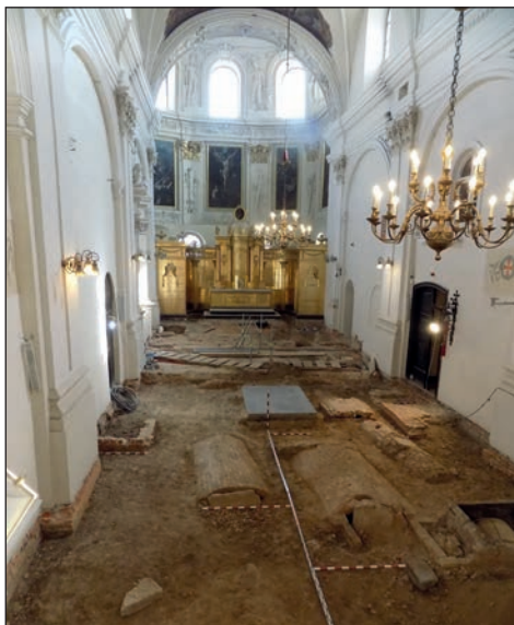
13. Lublin, ul. Złota, Bazylika pw. św. Stanisława. Odsłonięte w trakcie remontowych krypty w prezbiterium i nawie głównej kościoła. Fot. J. Tkaczyk
