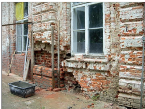
7. Udrycze, dwór, fragm. elewacji w trakcie prac remontowych, fot. Del. w Zamościu, 2012.
