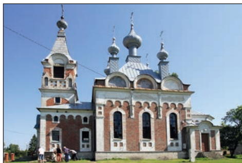
2. Sławatycze, cerkiew przed remontem, fot. Del. Biała Podl., 2014.
