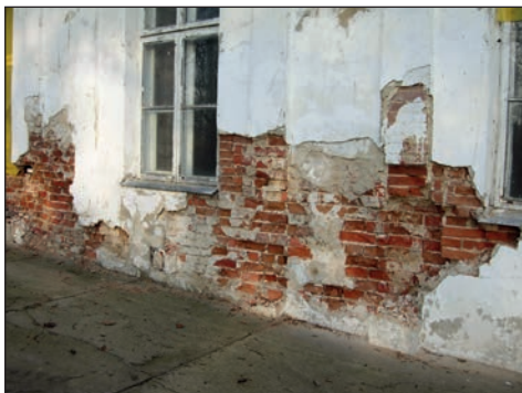
2. Udrycze, dwór, fragm. elewacji przed remontem, fot. Del. w Zamościu.
