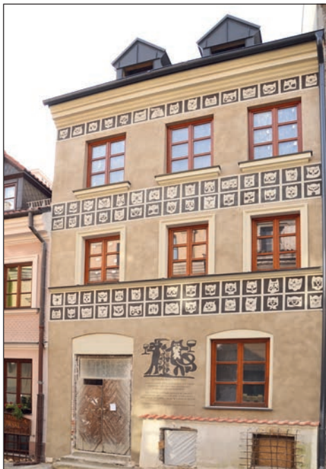
31. Lublin, ul. Grodzka 17, stan elewacji po remoncie, fot. K. Tur-Marciszuk, 2017.
