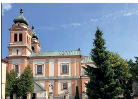
2. Biłgoraj, kościół pw. Trójcy Świętej i Wniebowzięcia NMP, fot. S. Starzyński.
