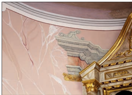
9. Buśno, kościół rzymskokatolicki pw. Wniebowzięcia NMP, polichromia ścienna po pracach, fot. P. Wira, 2017 r.
