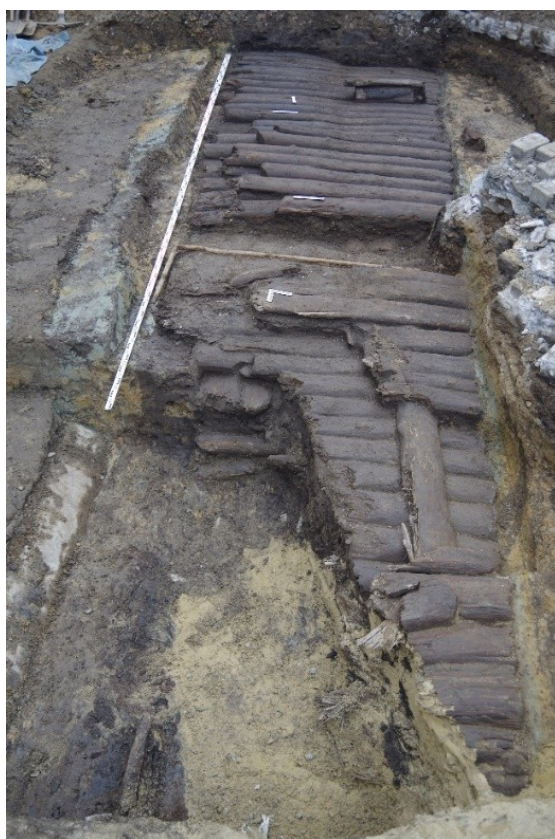
Pierwszy poziom drewnianej nawierzchni ul. 3 Maja w Rzeszowie
