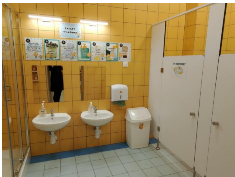
Zdjęcie nr 4. Wyremontowane sanitariaty w Oddziale Przedszkolnym w Starym Gołębinie
