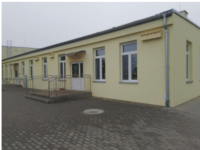
Zdjęcie nr 1. Wyremontowana część budynku przeznaczona na Oddział Przedszkolny w Starym Gołębiniu
