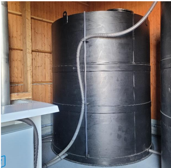
Fot. 1 i 2 Po lewej zbiornik do składowania roztworu chlorku sodu lub wapnia nazywanej powszechnie „solanką”, po prawej – magazyn materiałów do zapobiegania śliskości (chlorek wapnia składowany w workach typu „big bag”).
