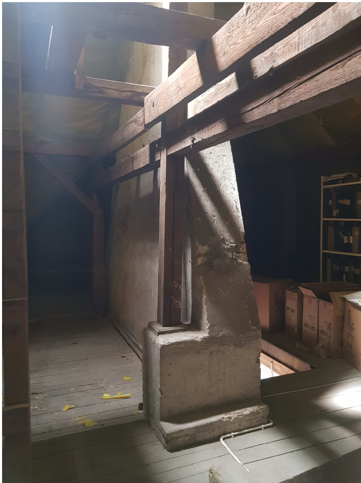
Zdjęcie numer 6 – widok na konstrukcję nośną dachu (oparcie na murze)
