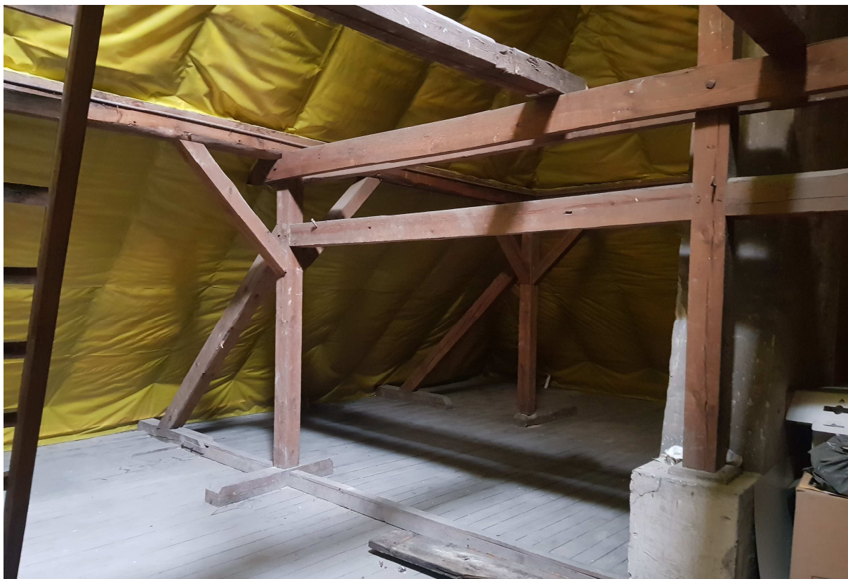
Zdjęcie numer 1 – widok układ konstrukcji dachu oraz strop drewniany zamknięty deskowaniem
