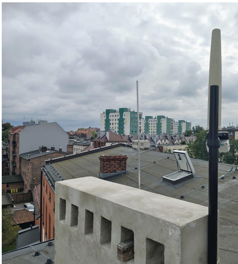
Rys. 3 Widok na SBTk z miejsca montażu SMS PEM – Szkoła Podstawowa nr 5 w Siemianowicach Śląskich
