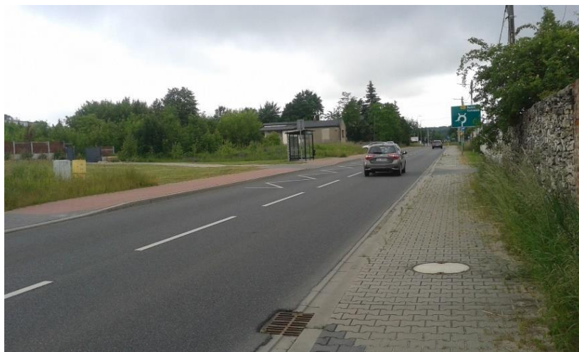
Fot. 6. Siemonia, gm. Bobrowniki, RB2. Badany odcinek ul. Młyńskiej w kierunku miejscowości Rogoźnik.
