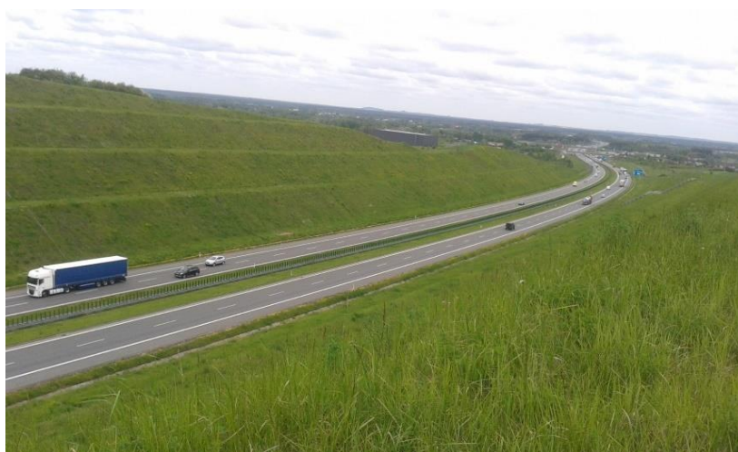
Fot. 11. Myszkowice, gm. Bobrowniki, RB4. Przebieg badanego odcinka autostrady A1 w kierunku Częstochowy.
