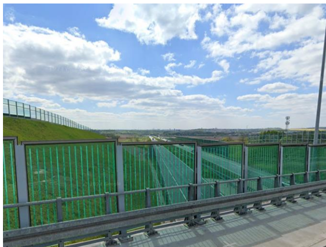
Fot. 15. Dobieszowice, gm. Bobrowniki, RB5. Przebieg badanego odcinka autostrady A1 w kierunku Gliwic.
