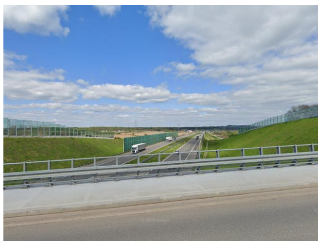
Fot. 14. Dobieszowice, gm. Bobrowniki, RB5. Przebieg badanego odcinka autostrady A1 w kierunku Częstochowy.
