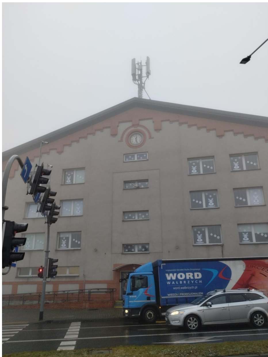
Rys. 3 Hala Wałbrzyskich Mistrzów – widok na SBTk z miejsca montażu SMS PEM
