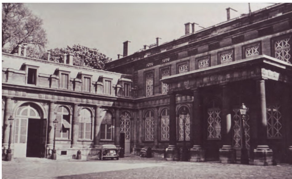
Budynek Ambasady RP w Paryżu, okna zabezpieczono taśmami, by odłamki szkła nie raniły pracowników podczas bombardowań, 1939 r. (IPMS)
