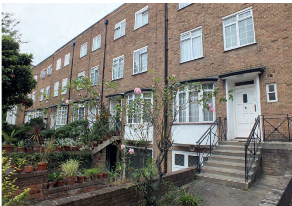
Budynki przy Porchester Terrace 9–13a, które miały być siedzibą Ministerstwa Spraw Zagranicznych, zdjęcie współczesne (AMSZ)
