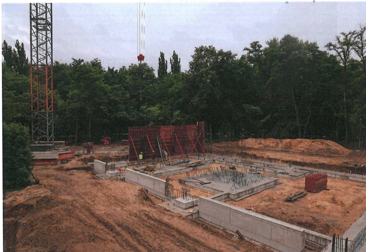
Fot. 10. Fundamenty pod budynek B.
