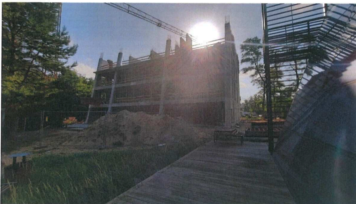
Fot. 12. Postęp prac budowlanych – budynek B.
