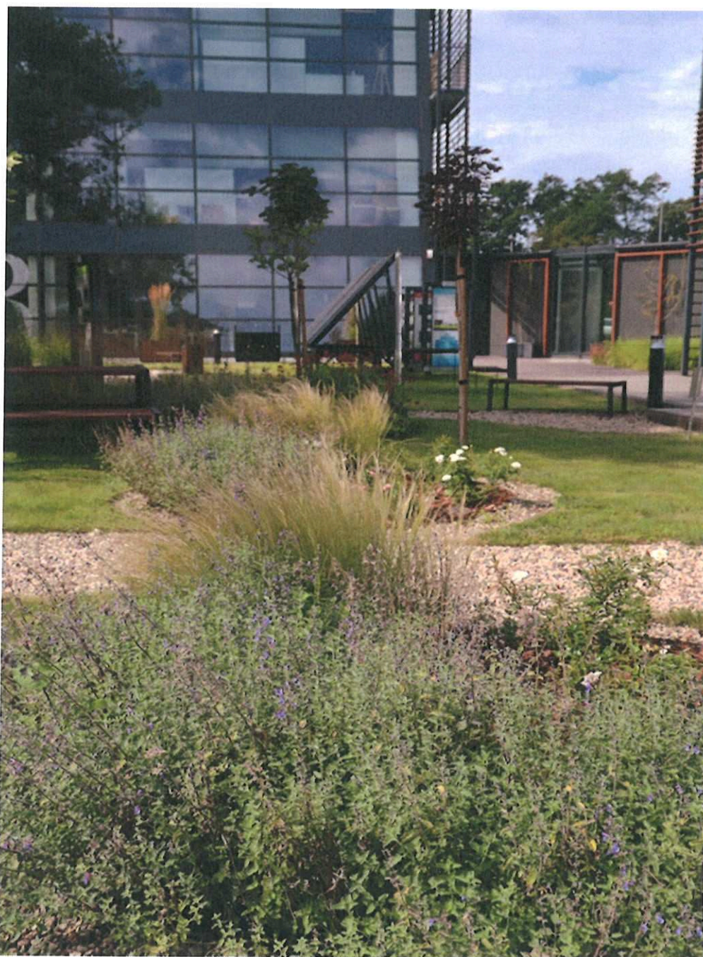
Fot. 4. Fragment północno-wschodniej elewacji Budynku B.
