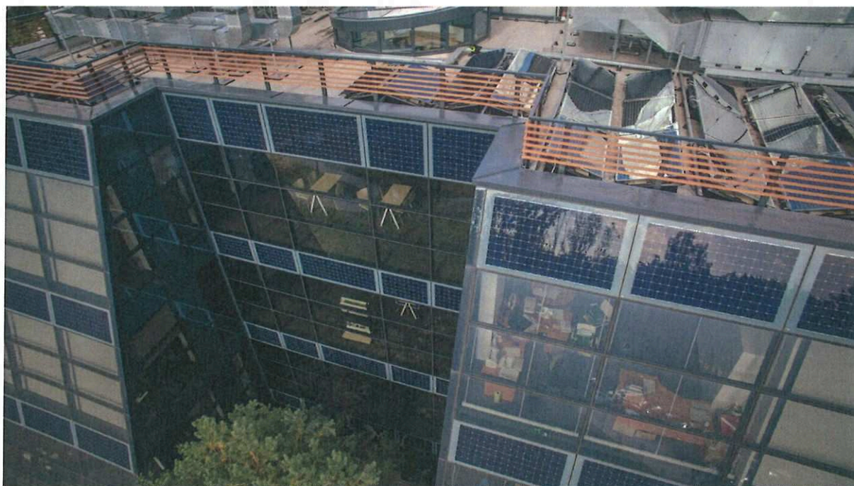
Fot. 6. Panele fotowoltaiczne na elewacji i dachu siedziby WFOŚiGW w Łodzi.
