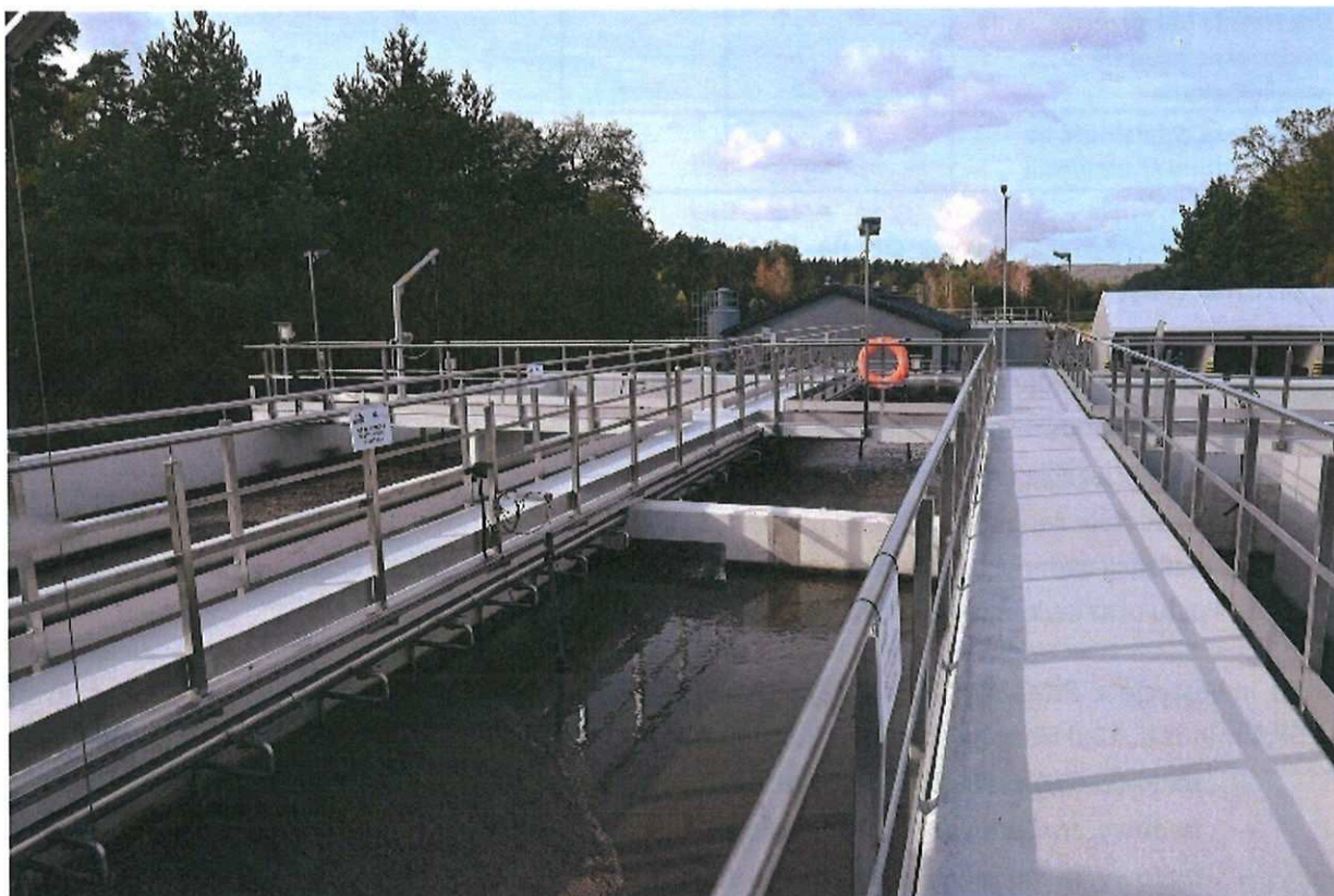
Fot. 20. Oczyszczalnia ścieków w Gomunicach
