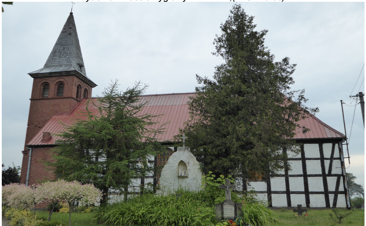
Drzewiany – kościół o konstrukcji szachulcowej z 1800 roku (T. Szmalec)
