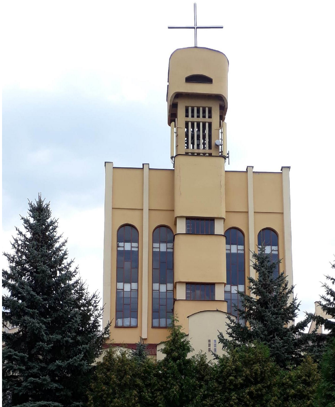
Fot. 2: Widoki anten stacji bazowej ID: RZE1022A, zlokalizowanej przy ul. Krakowskiej 18b w Rzeszowie
