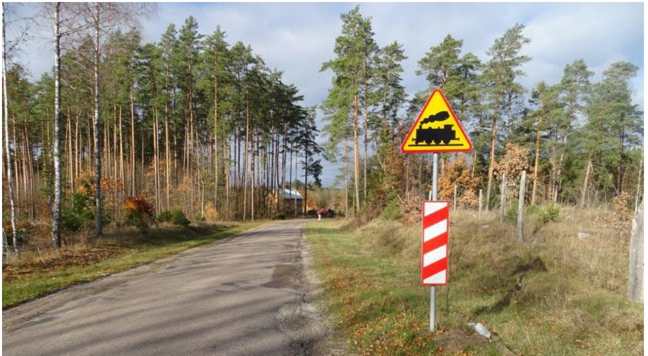
Zdjęcie 6. Znak A10, G1a ustawiony ok. 160 m przed przejazdem kolejowym (źródło: komisja kolejowa)
