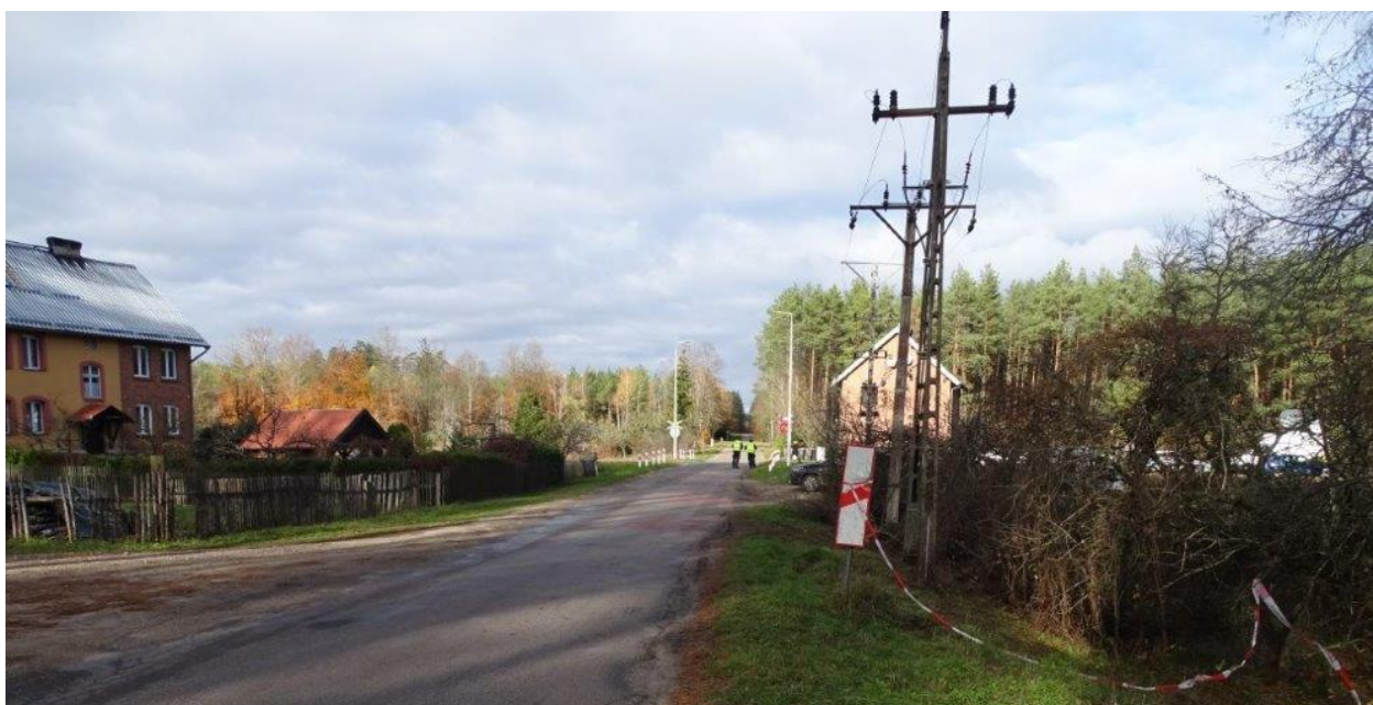
Zdjęcie 8. Znak G-1c ustawiony ok. 60 m przed przejazdem kolejowym (źródło: komisja kolejowa)
