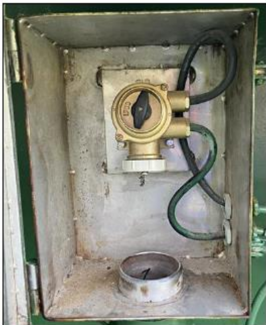
Rysunek 4: Skrzynka elektryczna z gniazdkiem
