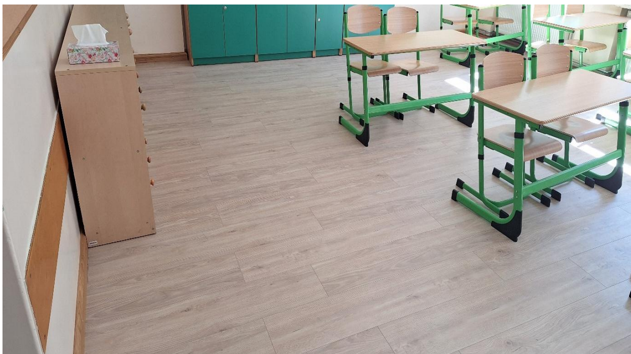
Zdjęcie 5. Podłoga po remoncie w Szkole Podstawowej im. Ziemi Biskupiańskiej w Starej Krobi
