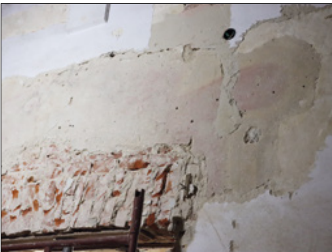
15. Korytarz północny w gmachu d. Akademii, iluzjonistycznie namalowany portal [fragment], w trakcie prac konserwatorskich, fot. K. Poździk, 2022
