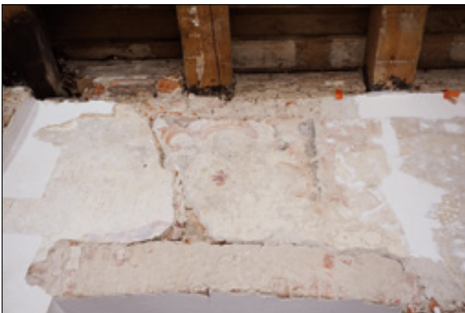
20. Sala 107, polichromia [fragment], 2 poł XVIII w. [?], w trakcie prac konserwatorskich, fot. K. Poździk, 2021
