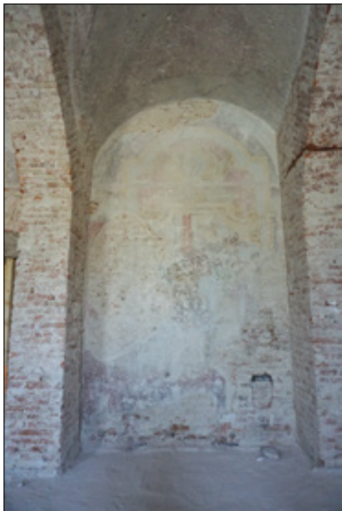
7. Sala W005, polichromia [fragment], XVIII w., w trakcie prac konserwatorskich, fot. K. Poździk, 2021
