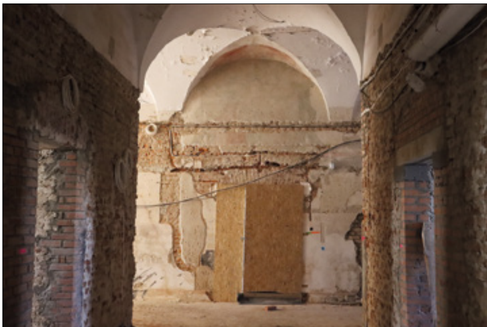
10. Polichromia nad wejściem do sali W005, XVIII w., w trakcie prac konserwatorskich, fot. K. Poździk, 2022
