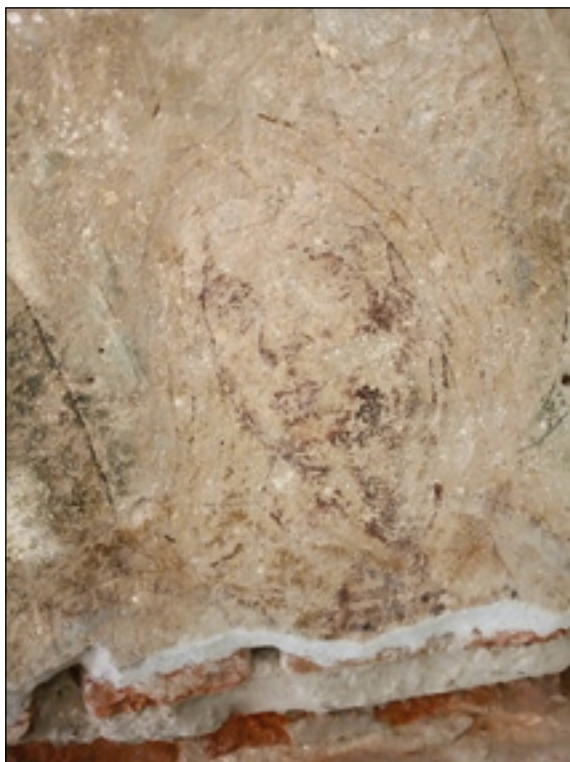
11. Polichromia nad wejściem do sali W005 [fragment], XVIII w. w trakcie prac konserwatorskich, fot. K. Poździk, 2020
