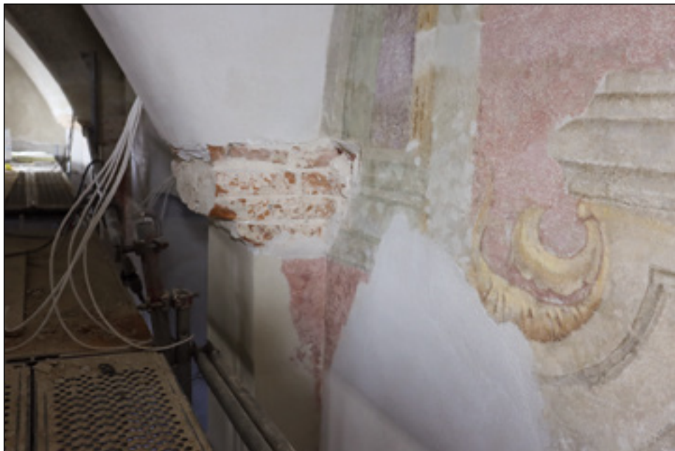
5. Sala W005, polichromia [fragment], XVIII w., w trakcie prac konserwatorskich, fot. K. Poździk, 2021
