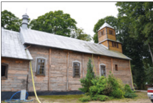
Fot. 6. Boża Wola, kościół parafialny pw. św. Antoniego Padewskiego, elewacja północna kościoła w trakcie prac, fot. I. Pałka, 2021
