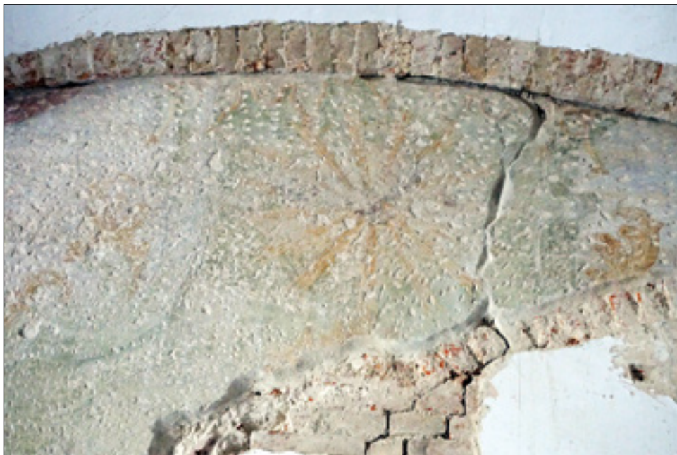
9. Sala W005, polichromia [fragment], XVIII w., w trakcie prac konserwatorskich, fot. K. Poździk, 2021
