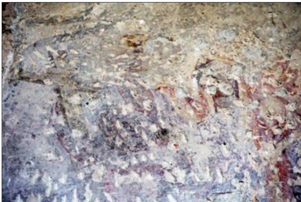
6. Sala W005, polichromia [fragment], XVIII w., w trakcie prac konserwatorskich, fot. K. Poździk, 2021
