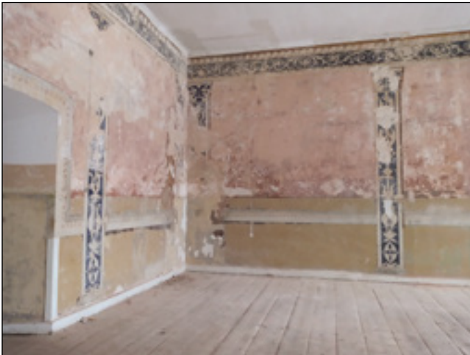
19. „Sala z kolumnami” na piętrze gmachu d. Akademii, w trakcie prac konserwatorskich, fot. K. Poździk, 2021
