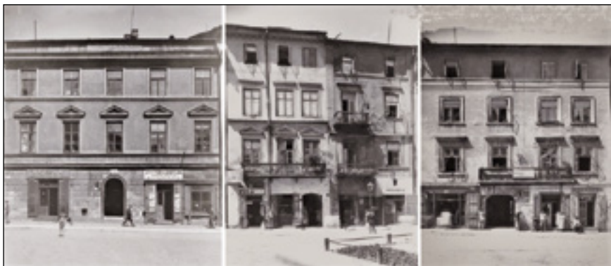
3. Elewacje kamienic, strona północna Rynku, zestawienie fot. z pocz. lat 30. XX w.
