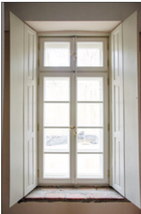
22. Dwór w Ciechankach po remoncie, nowa stolarka okienna z oryginalną okiennicą, fot. M. Kurczewicz, 2021
