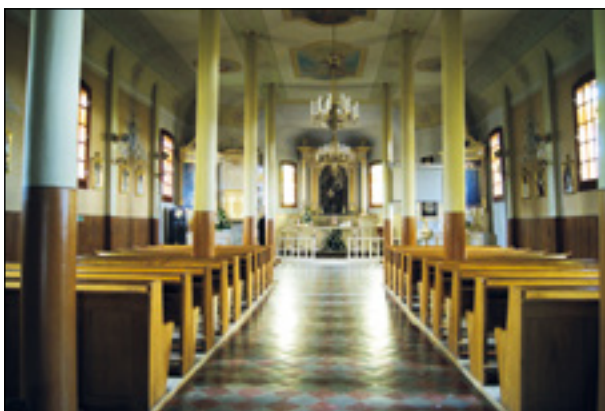
Fot. 2. Boża Wola, kościół parafialny pw. św. Antoniego Padewskiego, wnętrze kościoła przed podjęciem prac, fot. K. Tur-Marciszek, 2016
