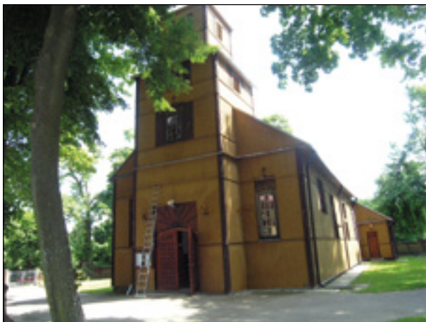
Fot. 1. Boża Wola, kościół parafialny pw. św. Antoniego Padewskiego, elewacja frontowa kościoła przed podjęciem prac, fot. K. Tur-Marciszek, 2016
