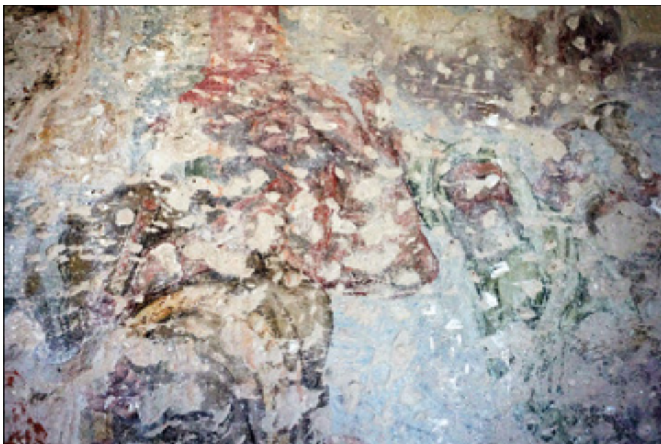
8. Sala W005, polichromia [fragment], XVIII w., w trakcie prac konserwatorskich, fot. K. Poździk, 2021
