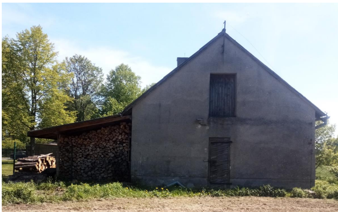
Fot.2. Elewacja północno – zachodnia.
