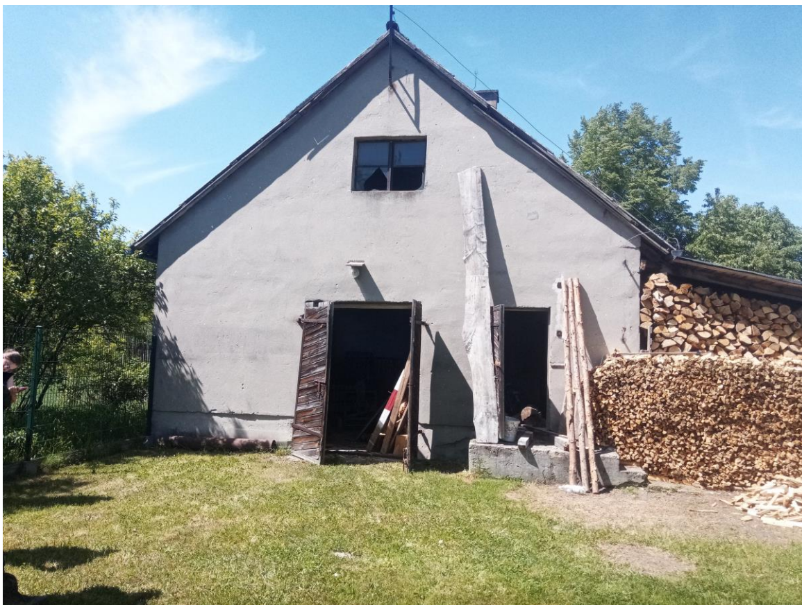
Fot.3. Elewacja południowo – wschodnia.
