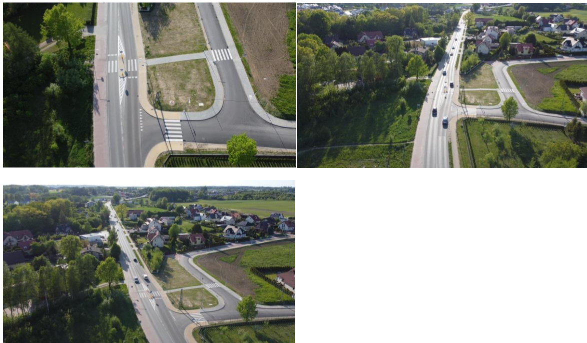
Zdjęcie 1. Przejście dla pieszych zmodernizowane dzięki realizacji projektu
