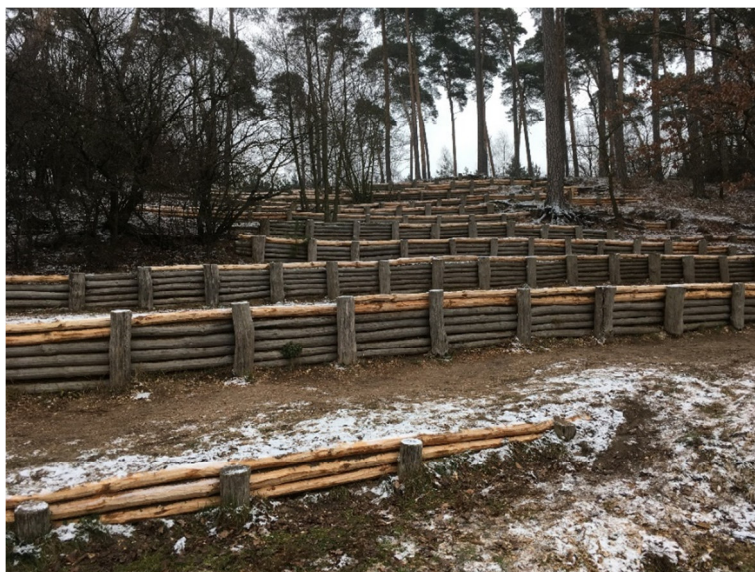
Fot. 6 Wyremontowane umocnienie skarpy przy Jeziorze Dębiniec.
