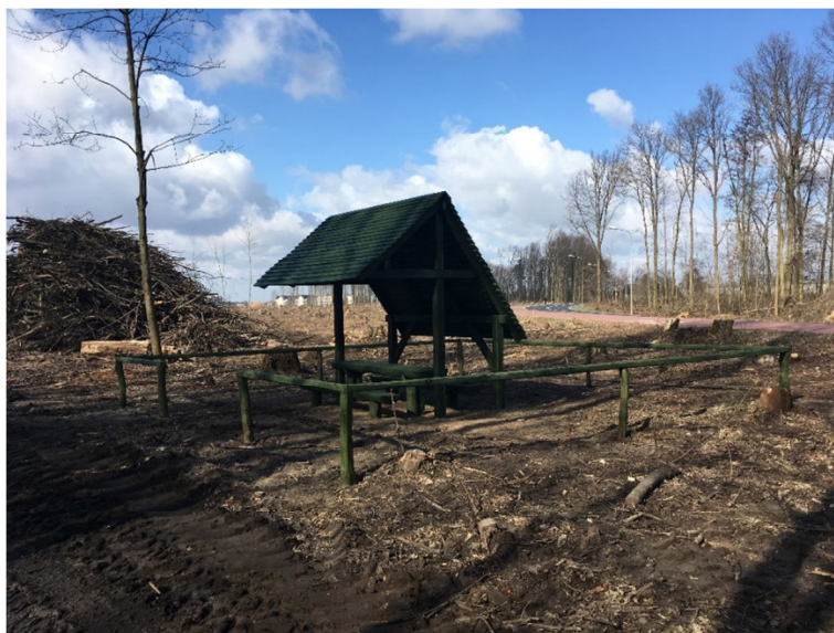
Fot. 7 Nowo wybudowane zadaszenie na terenie obszaru klęski.
