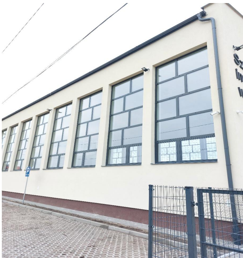
Fot. 5 sala gimnastyczna przy Szkole Podstawowej w Osinach
