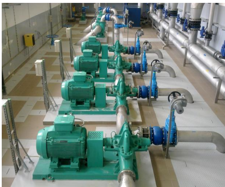
Hala pomp ujęcia wody w Trębowcu
