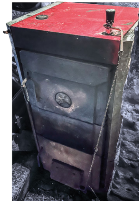
Zdj. 4. kocioł c.o. z ręcznym zasypem paliwa w miejscu stałego użytkowania, zasilany zarówno węglem kamiennym sortyment orzech jak i kostka oraz drewnem kawałkowym, pozaklasowy, niespełniający kryteriów ekoprojektu
