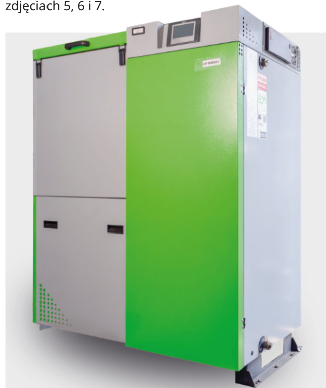
Zdj. 5. Kocioł c.o. z automatycznym zasypem paliwa, zasilany węglem kamiennym sortyment groszek, spełniający kryteria 5 klasy i ekoprojektu. Jest to kocioł z palnikiem retortowym, tzw. „retorta”
