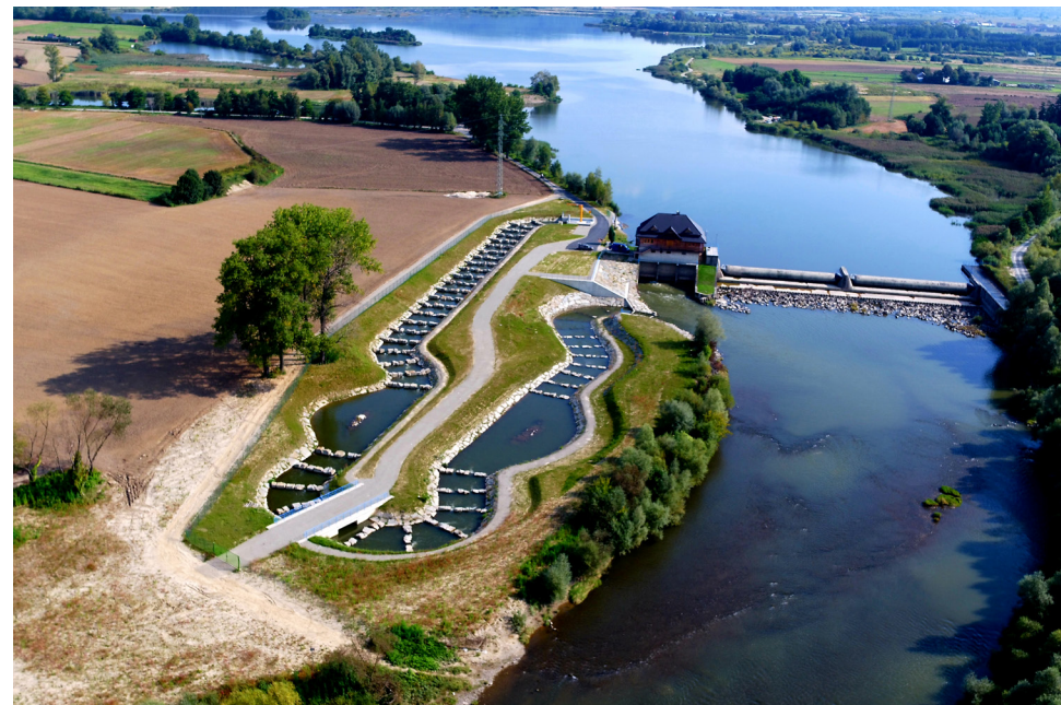
Przeławka wybudowana w ramach projektu „Likwidacja barier migracyjnych dla organizmów wodnych na rzece Wisłocy i jej dopływach – Ropie oraz Jasiołce”
