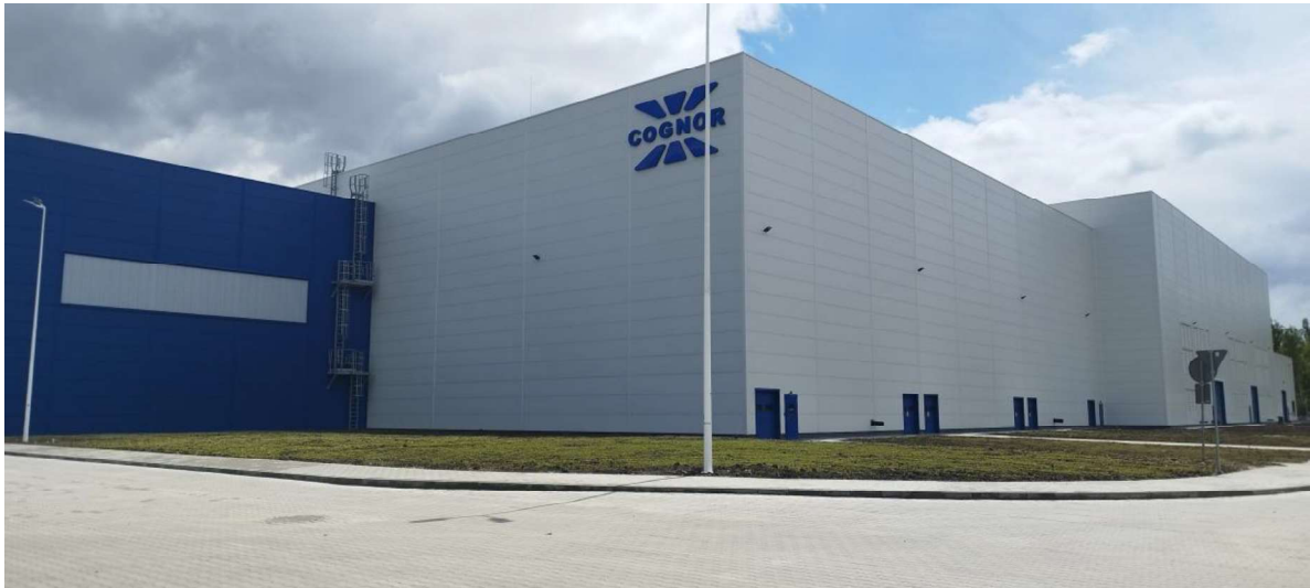
Hala produkcyjno-magazynowa walcowni kształtowników gorącowalcowanych (źródło własne)
