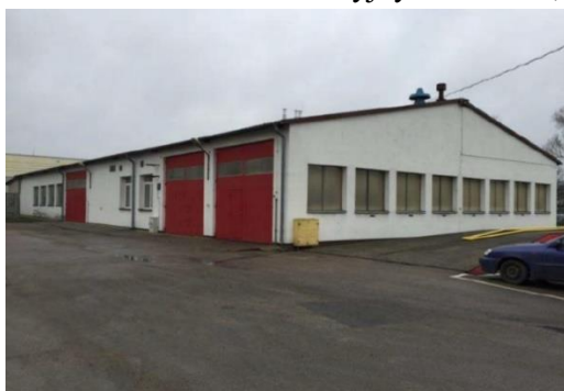
Budynek sprzed termomodernizacji Fot. KP PSP w Mławie
