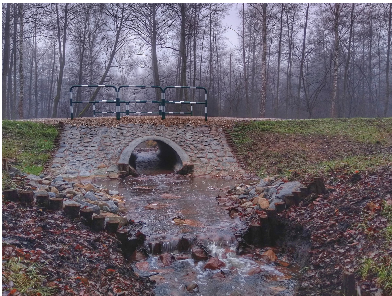
Fotografia nr 1. Przepust wykonany w ramach Programu Małej Retencji w Nadleśnictwie Niepołomice
