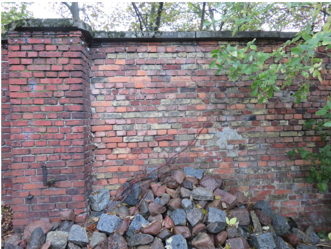
Fot. 1. Widok określający stan techniczny muru - spoiny w poziomie, brak zarysowań.
