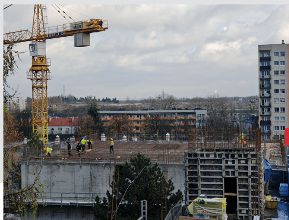
Stan prac w AP w Katowicach na koniec 2024 r. – budynek magazynowy nr 3, fot. Grupa NDI
