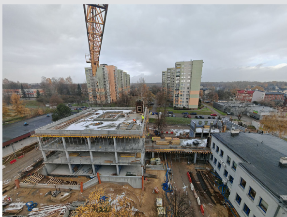
Stan prac w AP w Katowicach na koniec 2024 r. – budynki nr 2 i nr 1 oraz łącznik, fot. Grupa NDI
