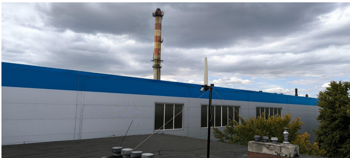
Rys. 3 Widok na SBTK z miejsca montażu SMS PEM – Budynek usługowy, Tarnowskie Góry
