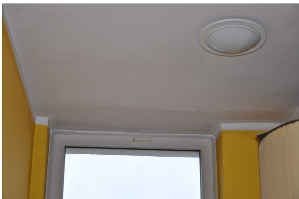
Fot. 19 Klawiszowanie stropu nad klatką schodową zachodnią
