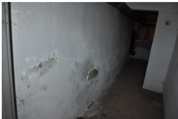
Fot. 1 Zawilgocenia na zachodniej ścianie piwnicy
