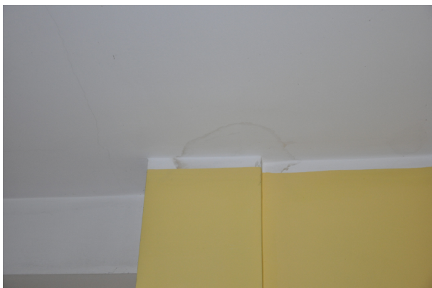
Fot. 17 Zawilgocenia stropu nad piętrem
