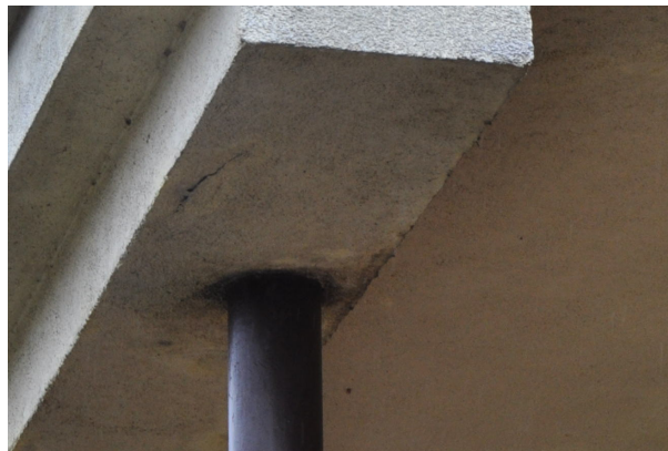
Fot. 14 Zarysowania podciągu przy słupie
