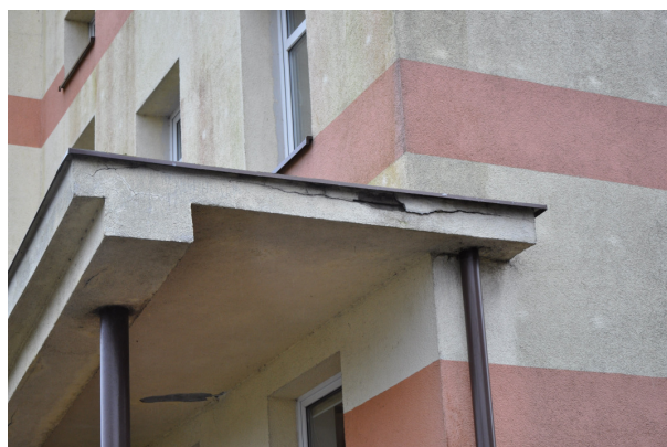
Fot. 20 Uszkodzenia daszku nad wejściem
