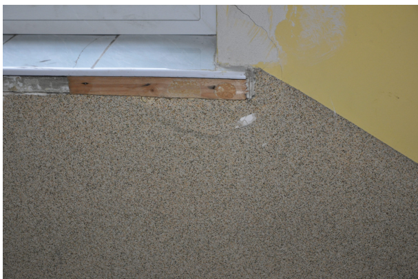
Fot. 5 Ślady zawilgocenia przy podokienniku, północna ściana klatki schodowej wschodniej
