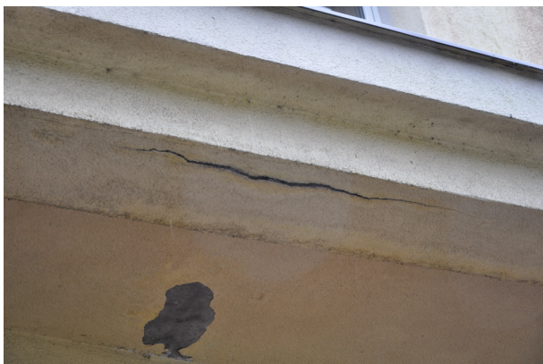
Fot. 13 Zarysowania podłużnej podciągu w środku przęsła
