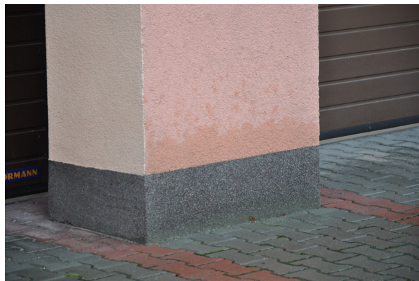
Fot. 10 Zawilgocenia tynku filarów w strefie cokołowej
