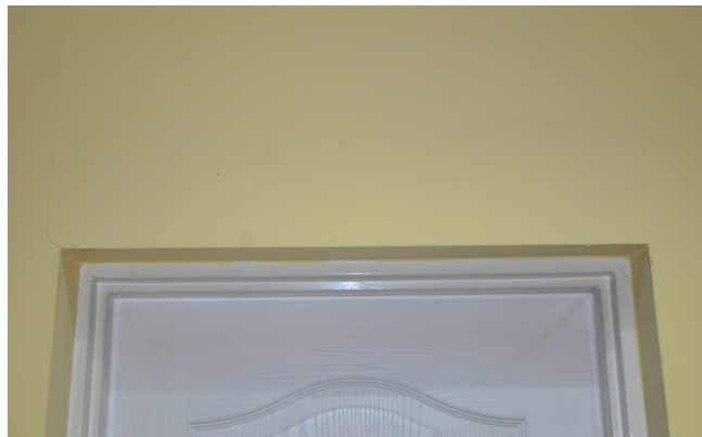
Fot. 12 Mikrorysy przy nadprożu drzwiowym – ściana wewnętrzna
