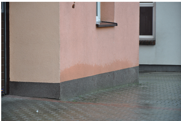
Fot. 9 Zawilgocenia tynku ścian w strefie cokołowej
