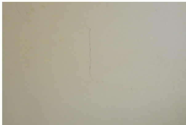
Fot. 4 Zarysowania na ścianie wewn. klatki schodowej, II. piętro
