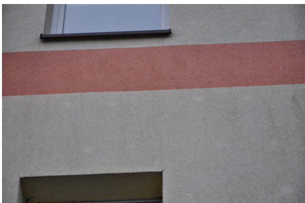
Fot. 7 Zarysowania wyprawy tynkarskiej na elewacji południowej
