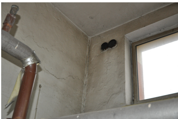
Fot. 3 Zarysowania ściany między garażem a kotłownią
