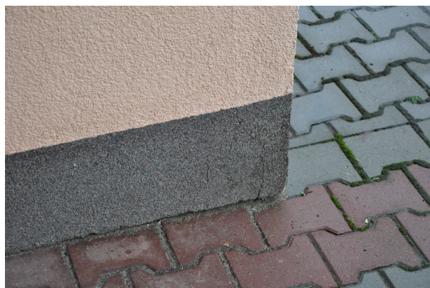
Fot. 8 Spękania tynku w strefie cokołowej
