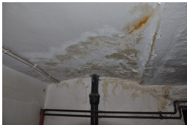
Fot. 18 Zawilgocenia stropu nad piwnicą, kotłownia
