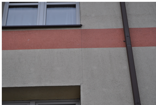
Fot. 6 Zarysowania wyprawy tynkarskiej na elewacji południowej
