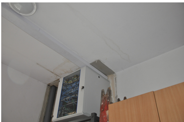
Fot. 15 Zawilgocenia stropu nad parterem
