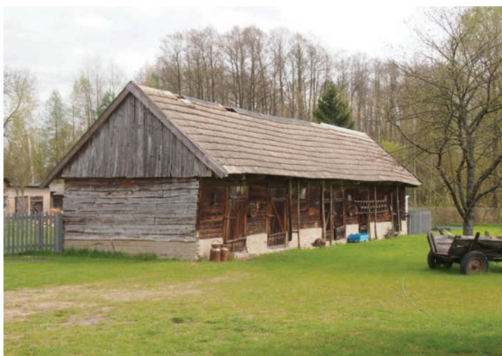
26. Plutycze. Budynek inwentarski w zagrodzie 6. Fot. I. Górską, 2021 Plutycze. The livestock building in the homestead 6. Photo by I. Górską, 2021
