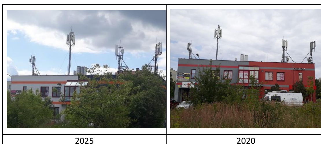
Rys. 8: Widok anten stacji bazowych – ID: KIE1046 oraz ID: 12947
