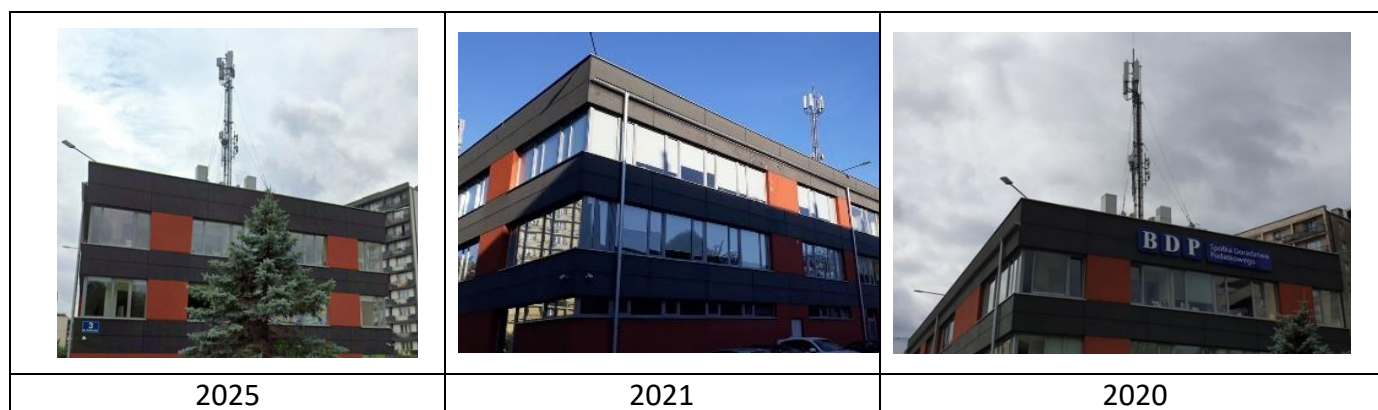
Rys. 14: Widok anten stacji bazowej – ID: 55314
