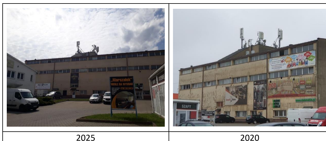
Rys. 22: Widok anten stacji bazowych – ID: KIE1016 oraz ID: 55315
