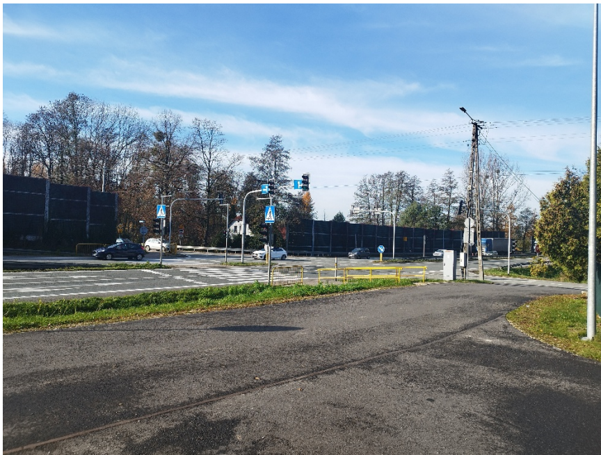
Fot. 3. Pawłowice ul. Wyzwolenia, RB1. Badany odcinek DK81, w kierunku Skoczowa.
