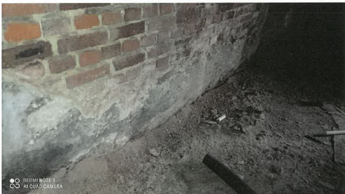
Zdj. 16. Ściana murowana, widoczna intensywna degradacja wypraw i ceramiki
