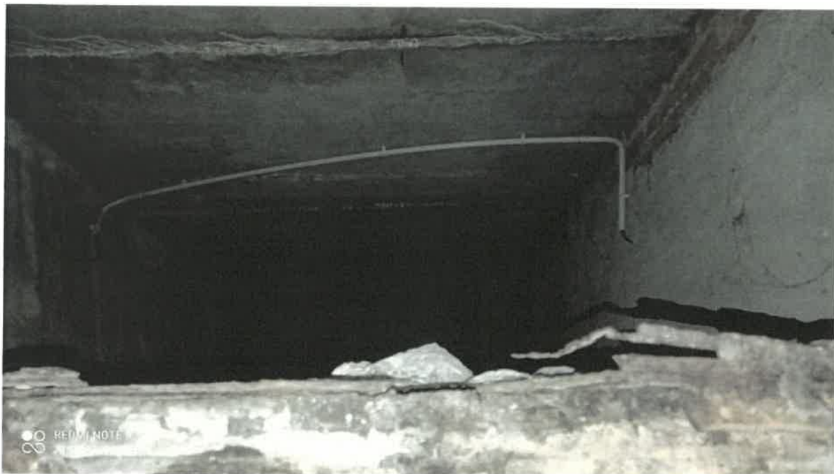
Zdj. 21. Strop zsypu, widoczne przecieki i zasolenie, widoczna korozja zbrojenia
