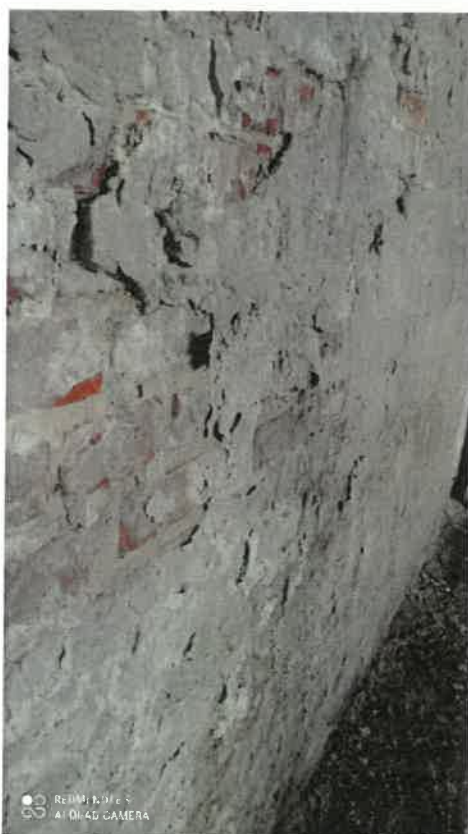
Zdj. 10. Ściana murowana, widoczna degradacja wypraw, liczne odparzenia tynku c-w
