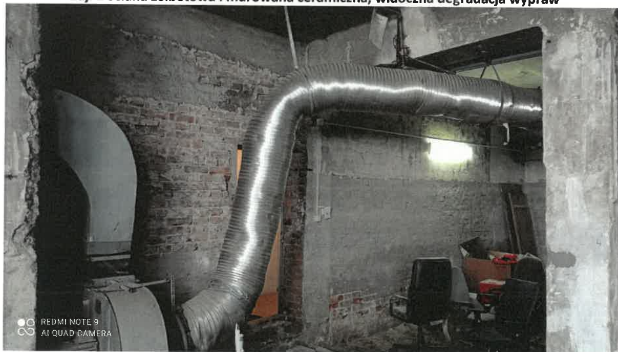
Zdj. 3 Ściana murowana, widoczny układ wypraw oraz postęp ich degradacji
