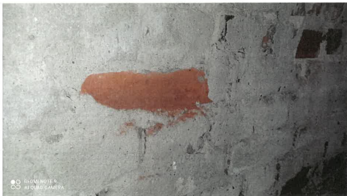
Zdj. 12. Widoczne pudrowanie ceramiki
