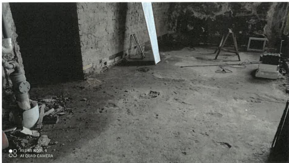
Zdj. 36. Posadzka pomieszczenia kotłowni, widoczne ubytki i ślady po zalaniu
