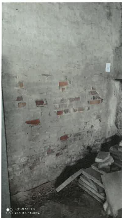
Zdj. 11. Ściana murowana, widoczna degradacja wypraw i pudrowanie ceramiki
