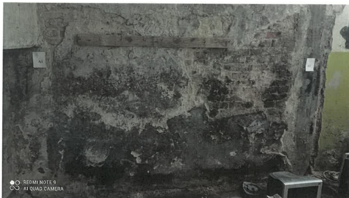
Zdj. 29. Ściana murowana, widoczna degradacja wypraw wierzchnich
