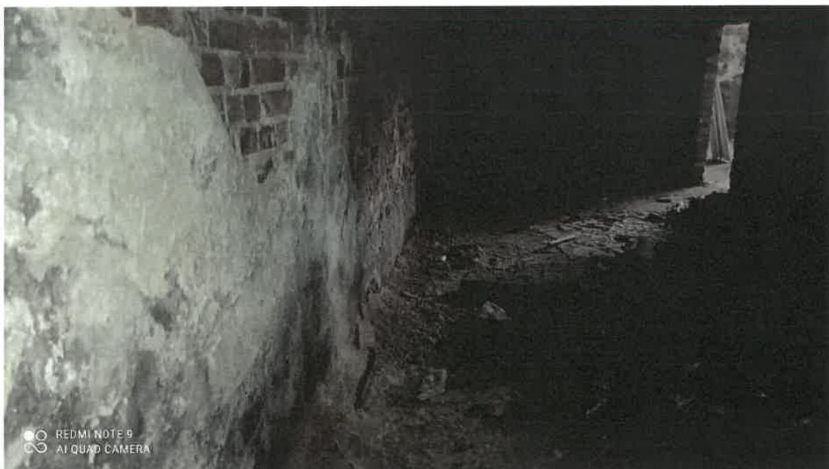
Zdj. 15. Ściana murowana, widoczna degradacja wypraw oraz ceramiki, bardzo intensywne pudrowanie tynku i ceramiki
