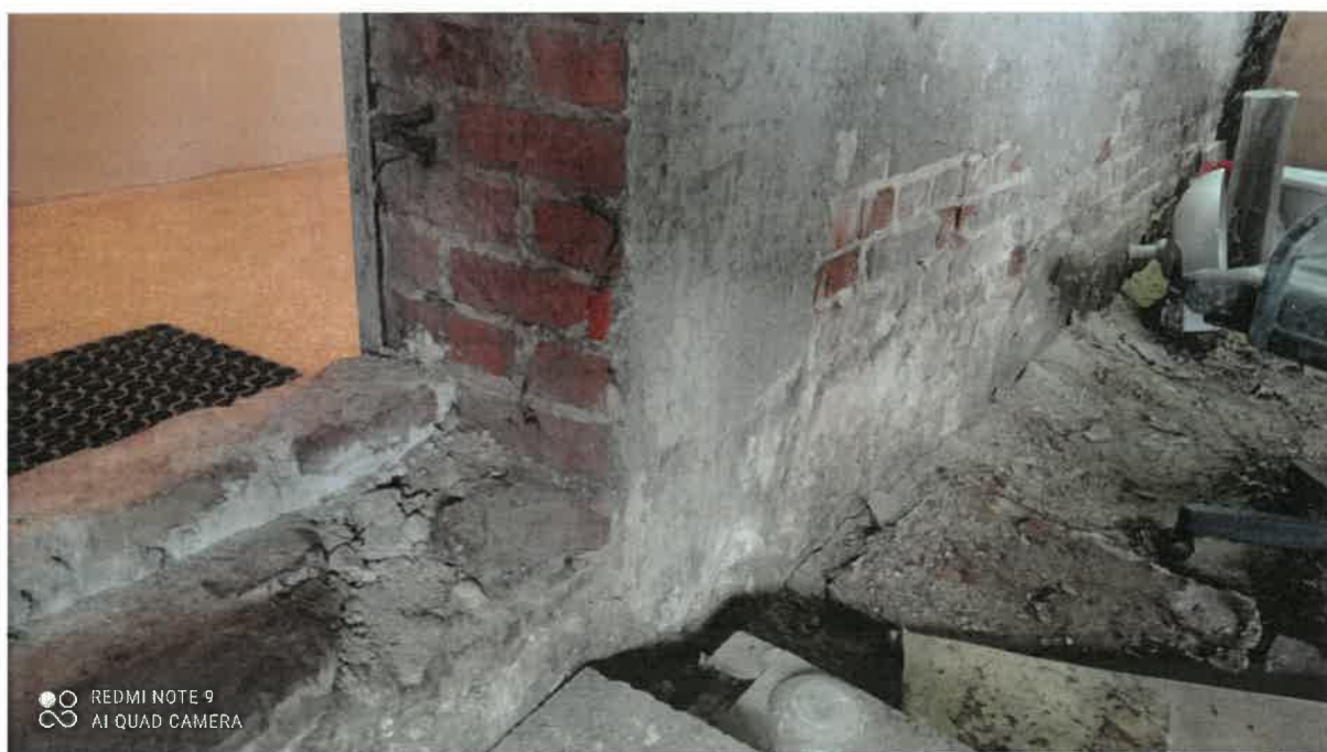
Zdj. 5. Ściana murowana, widoczna degradacja oraz różnica poziomów posadzek pomieszczeń
