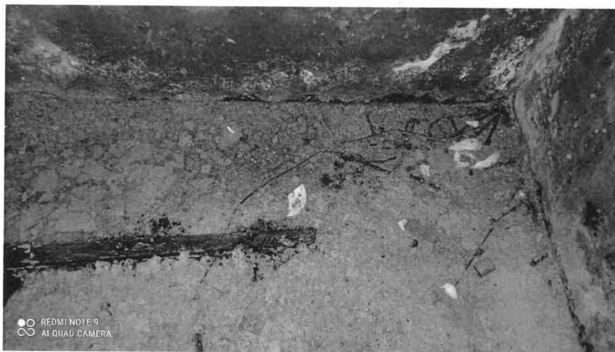
Zdj. 14. Widoczne znaczne zawilgocenie klepiska w zsypie węgla
