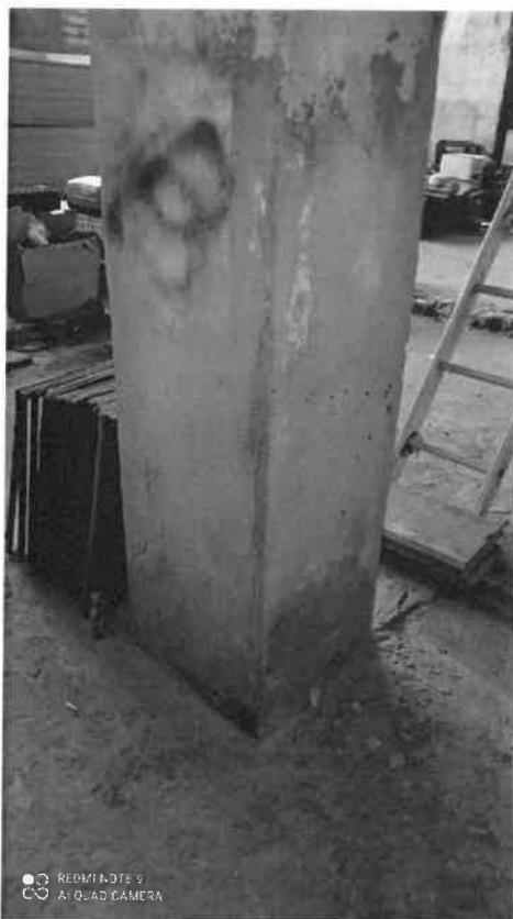
Zdj. 33. Słup żelbetowy, widoczne wysolenia
