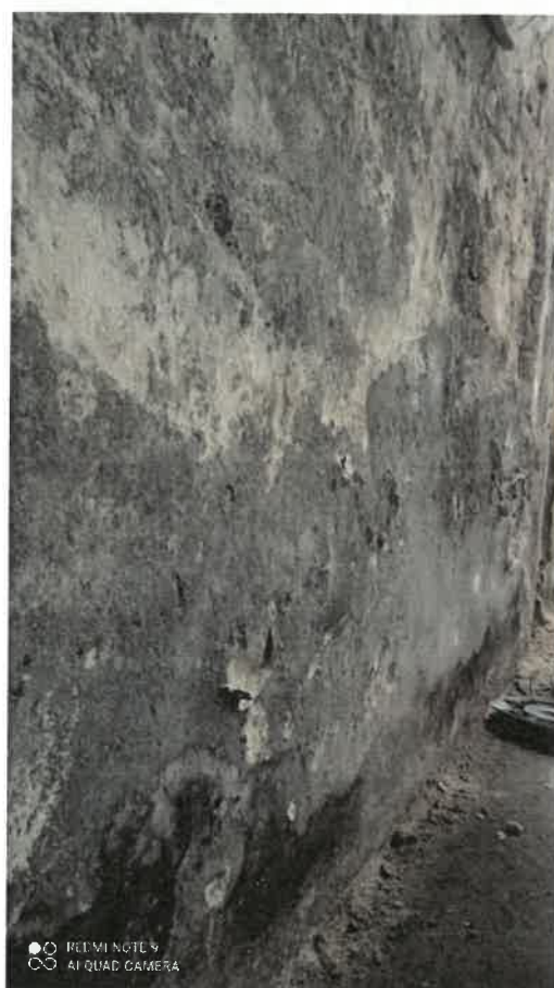
Zdj. 30. Ściana murowana, widoczne wysolenia i odparzenia powłok malarskich
