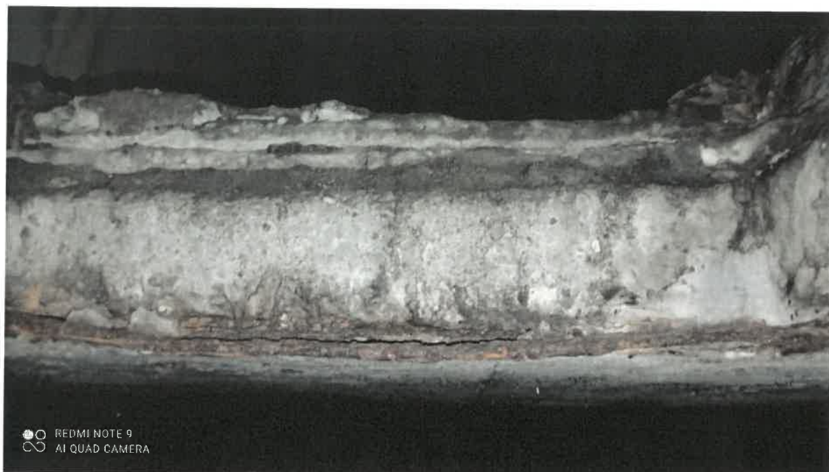
Zdj. 25. Właz w stropie pośrednim zsyphu, widoczna intensywna korozja
