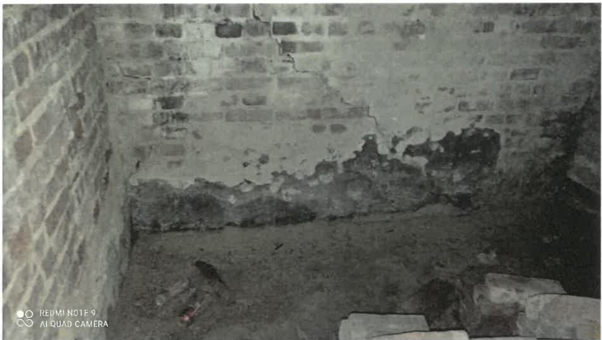
Zdj. 19. Ściana murowana, widoczna degradacja wypraw i ceramiki
