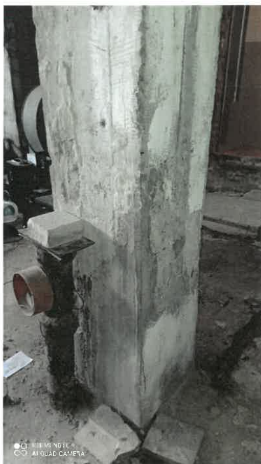
Zdj. 35. Słup żelbetowy, widoczne wysolenia, widoczny sposób prowadzenia instalacji
