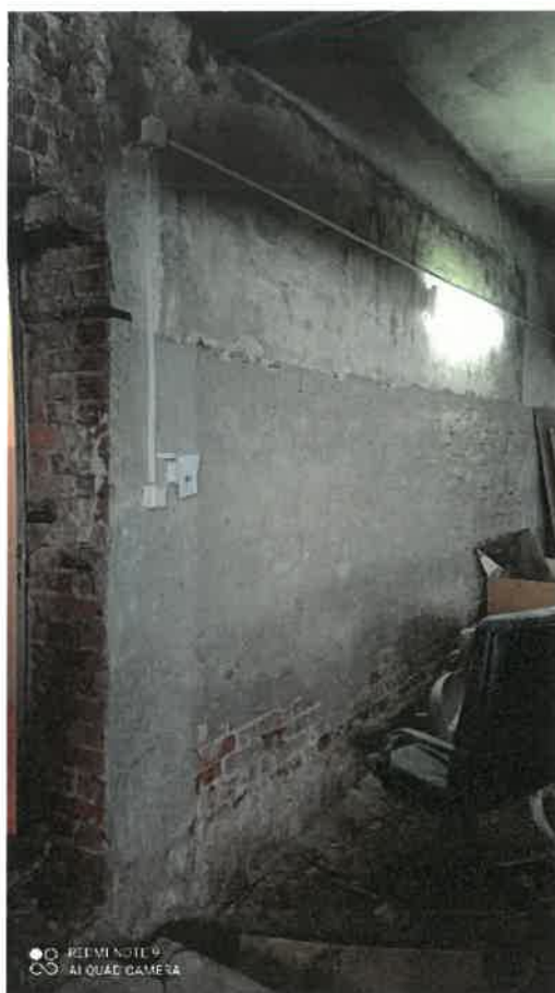
Zdj. 4. Ściana murowana, widoczny układ wypraw oraz postęp ich degradacji
