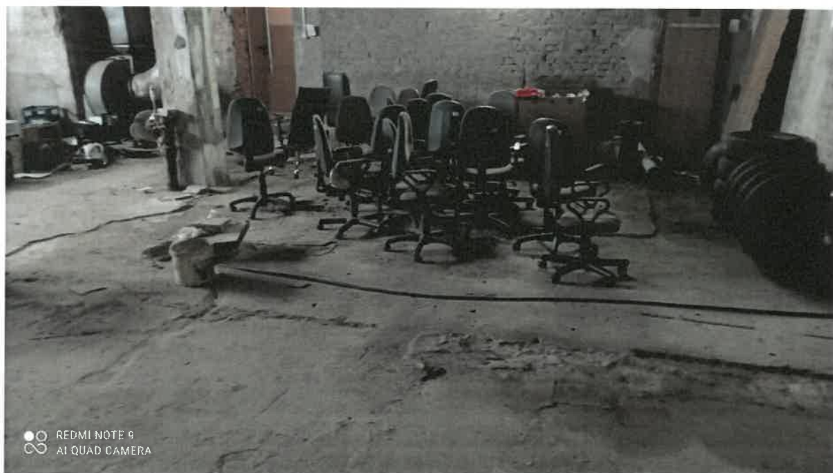
Zdj. 38. Posadzka byłej kotłowni, widoczna pozostałość po ścianie ceramicznej oraz zawilgocenie przy niej
