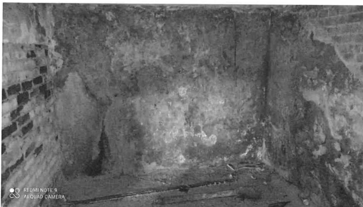
Zdj. 13 Ściana murowana, widoczna intensywna degradacja wypraw, znaczne zawilgocenie klepiska
