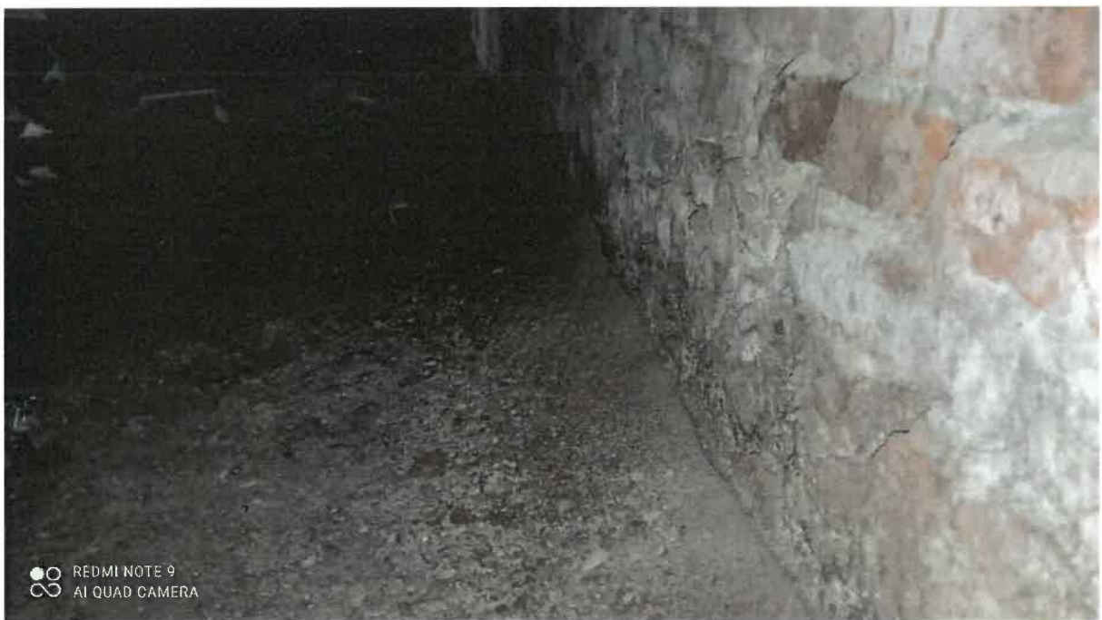
Zdj. 20. Ściana murowana, widoczne bardzo intensywne pudrowanie
