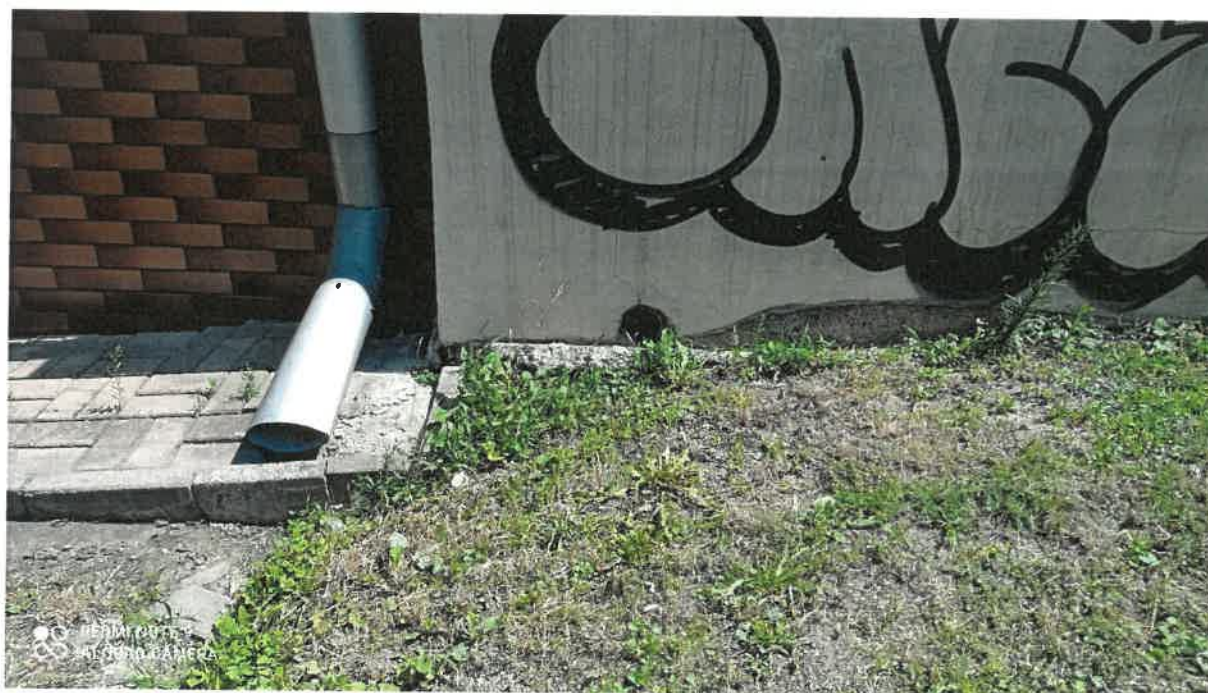
Zdj. 42. Widoczny otwór w ścianie zsypu
