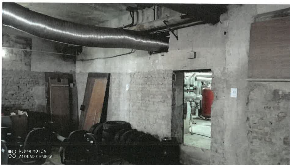
Zdj. 7. Ściana murowana, widoczny stan wypraw, przebicia instalacyjne oraz murek w otworze drzwiowym
