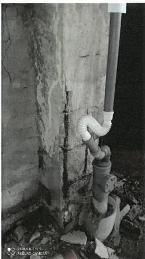
Zdj. 32. Słup żelbetowy, widoczna degradacja, odsłonięcie zbrojenia, widoczny sposób prowadzenia instalacji
