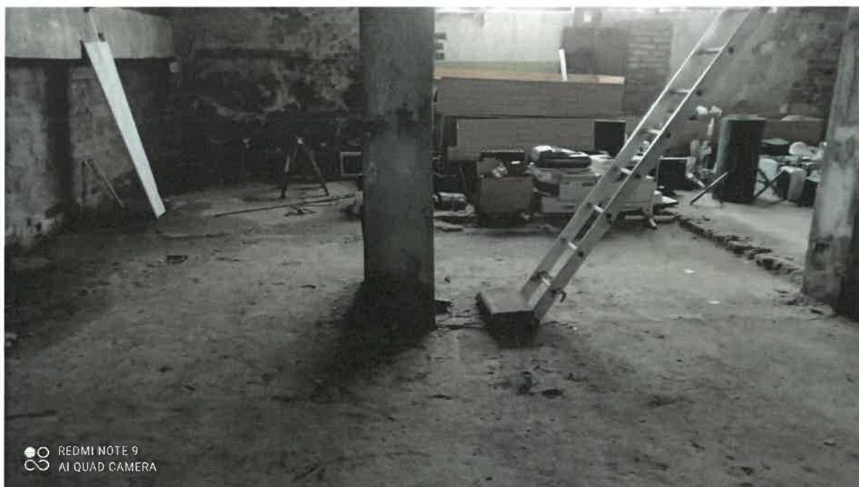
Zdj. 39. Posadzka byłej kotłowni, widoczna degradacja posadzki i słupów
