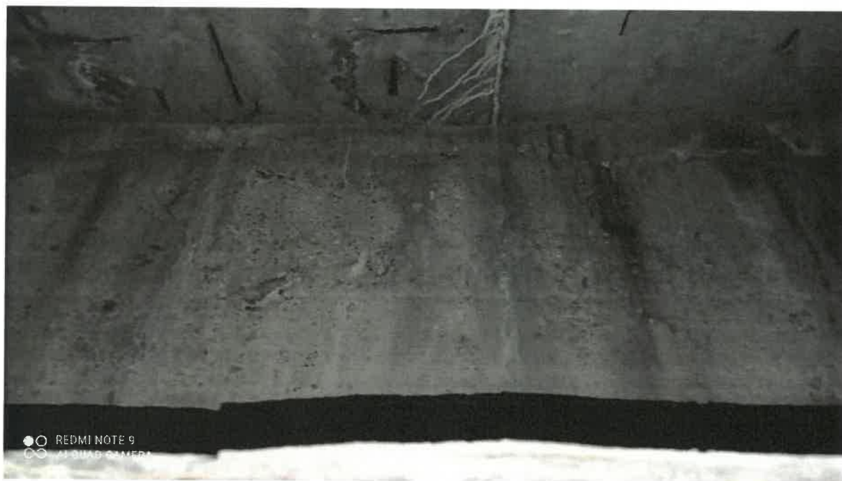
Zdj. 22. Strop zsypu, widoczne przecieki i zasolenie, widoczna korozja zbrojenia
