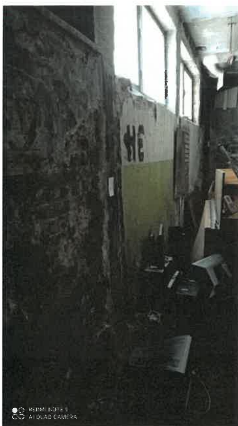
Zdj. 31. Ściana murowana, widoczna degradacja wypraw wierzchnich
