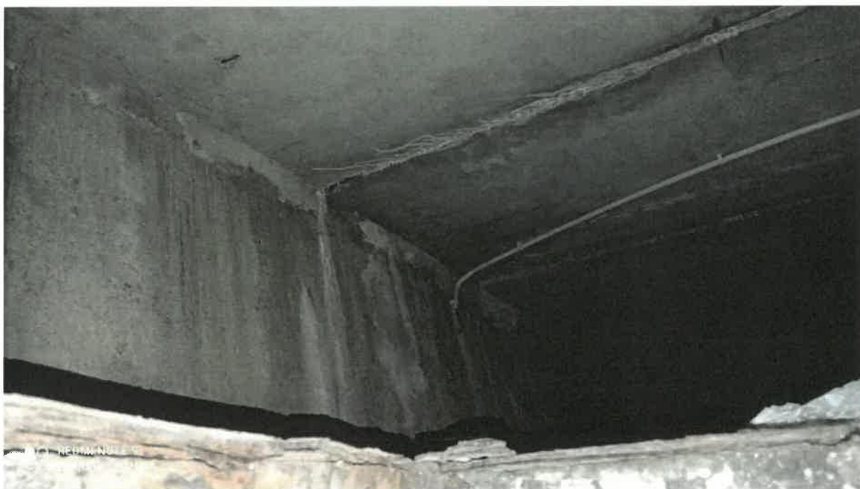
Zdj. 23. Strop i ściana zewnętrzna zsyu, widoczne przecieki i wysolenia
