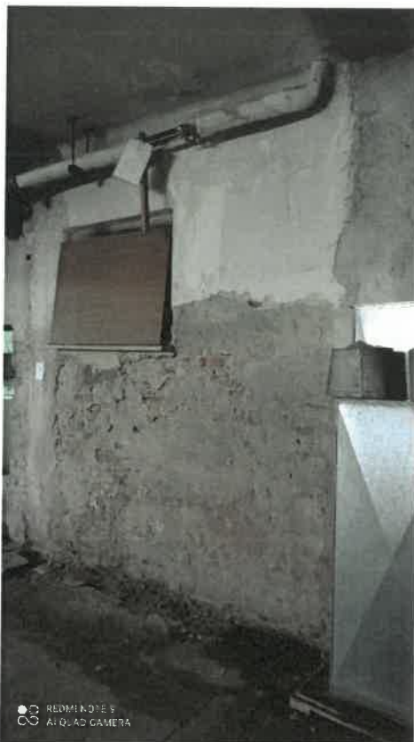
Zdj. 9. Ściana murowana, widoczny stan wypraw wierzchnich, otwór okienny i słup żelbetowy
