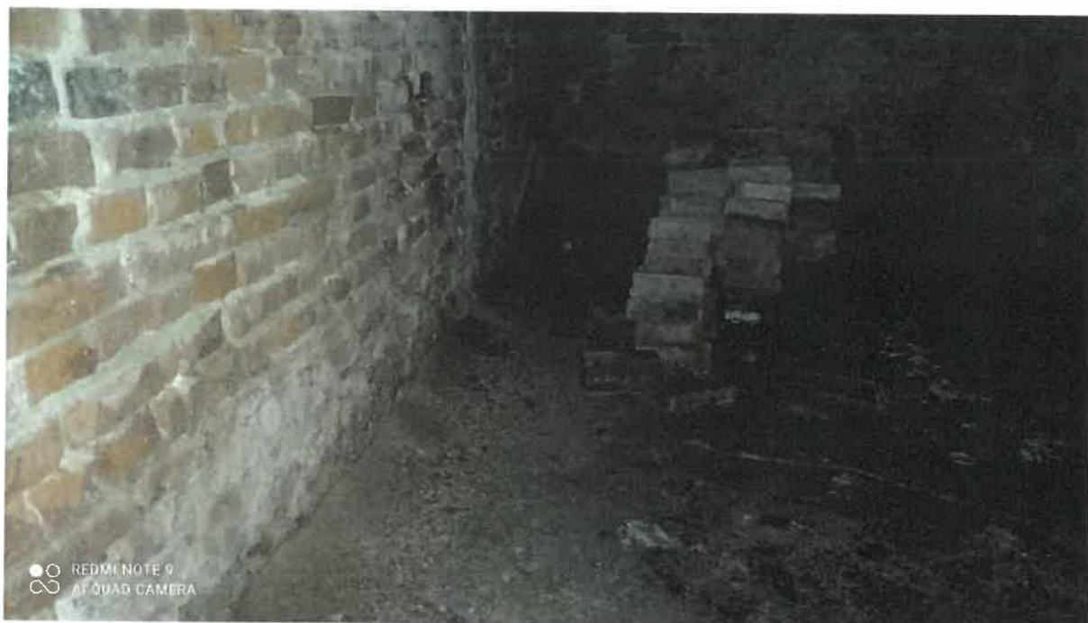
Zdj. 17. Ściana murowana, widoczna degradacja ceramiki, intensywne pudrowanie
