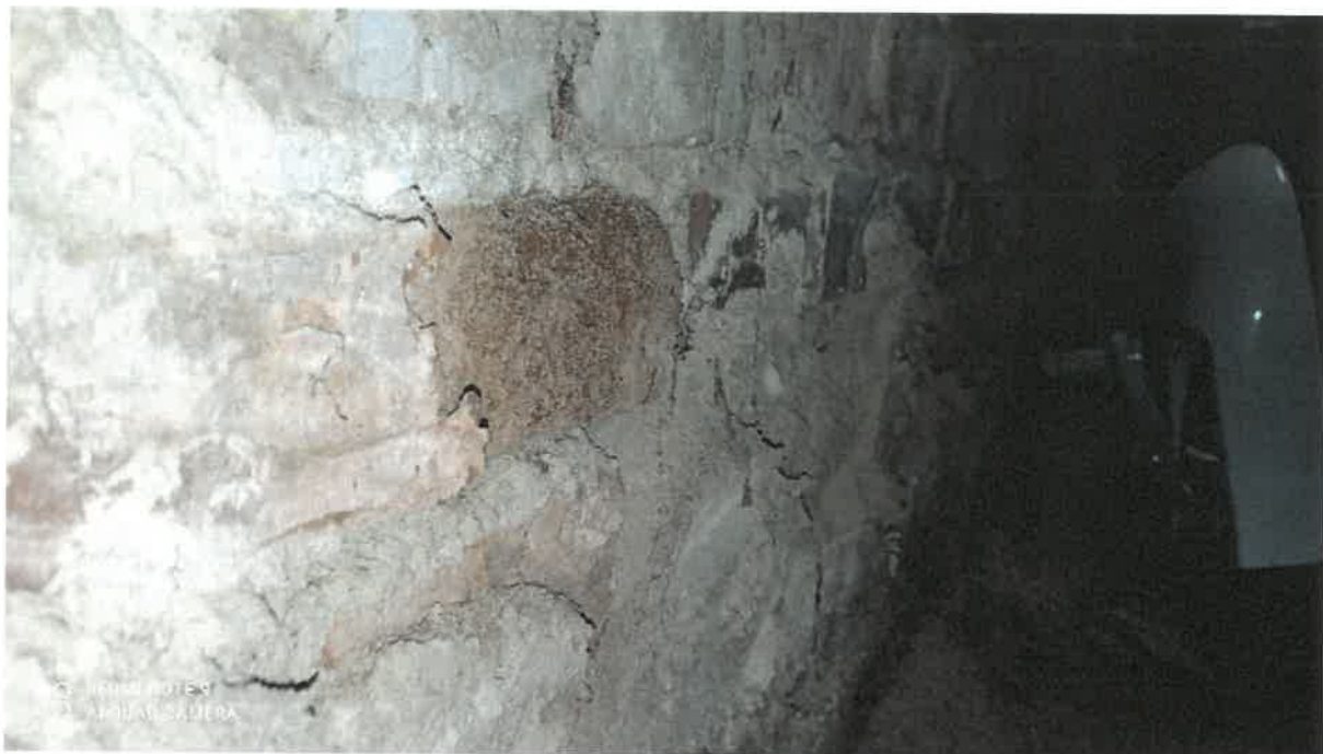
Zdj. 6. Ściana murowana, widoczne wysolenie i rozwarstwienia ceramiki oraz tynku c-w
