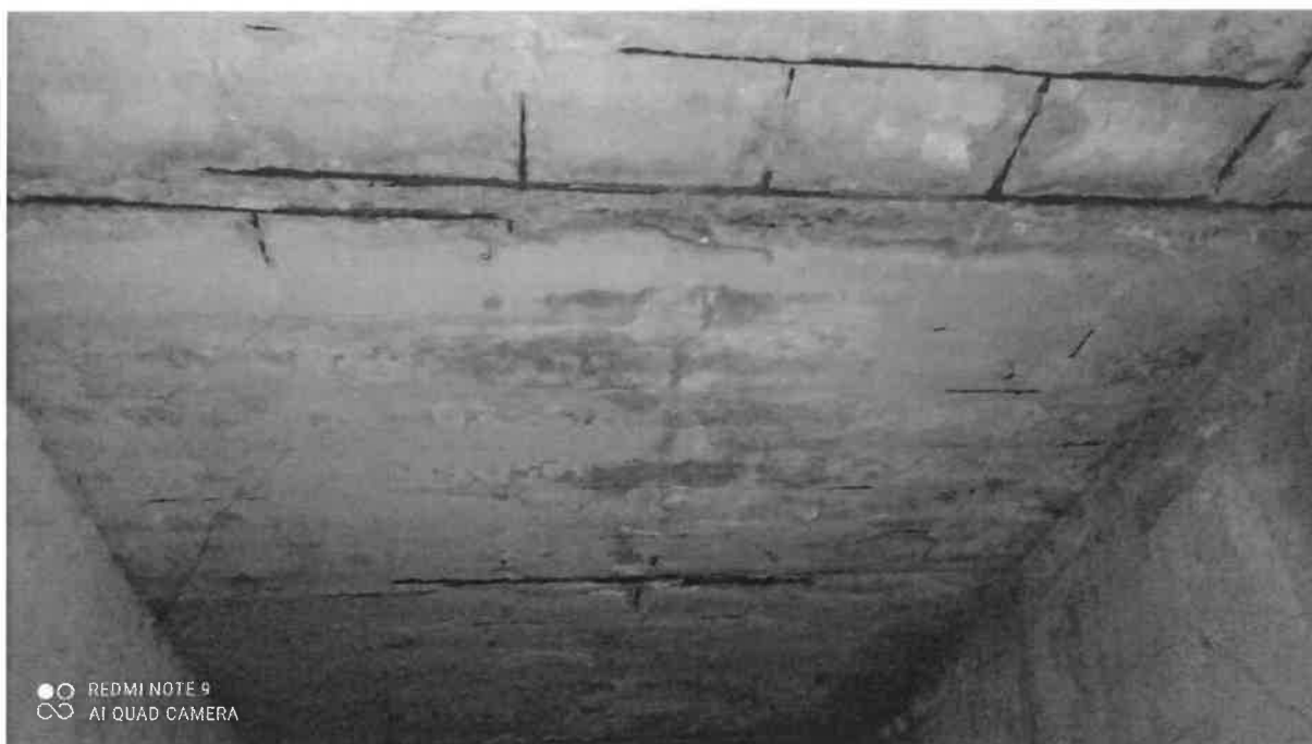
Zdj. 27. Strop zsypu, widoczne odsłonięcie zbrojenia
