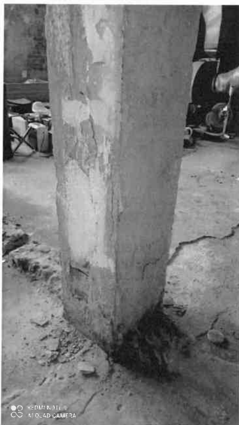
Zdj. 34. Słup żelbetowy, widoczne wysolenia i odparzenia szpachli
