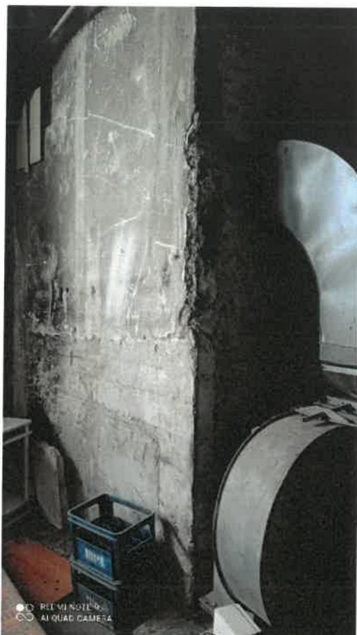
Zdj. 2 Ściana żelbetowa i murowana ceramiczna, widoczna degradacja wypraw
