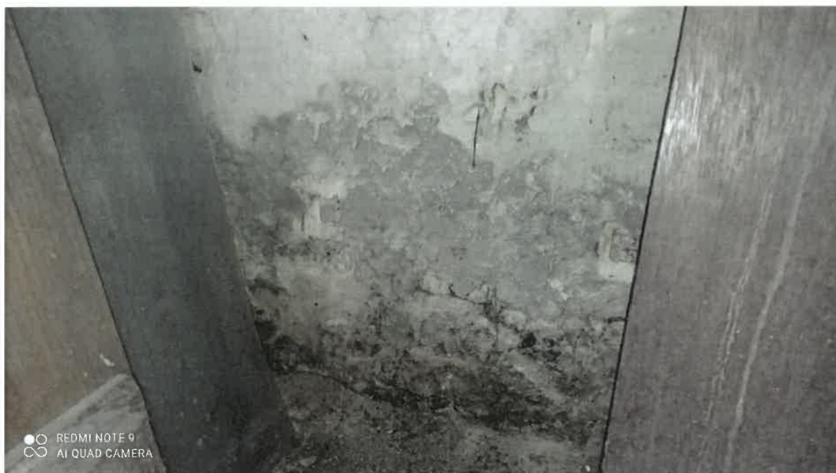
Zdj. 8. Ściana murowana, widoczna degradacja wypraw
