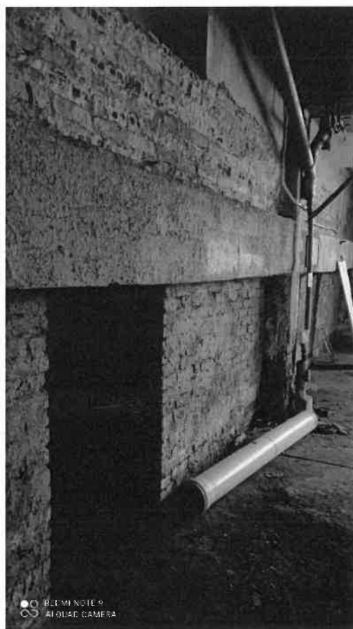
Zdj. 28. Ściana działowa zsyp – pomieszczenie kotłowni, widoczny stan wypraw oraz uszkodzenie słupa
