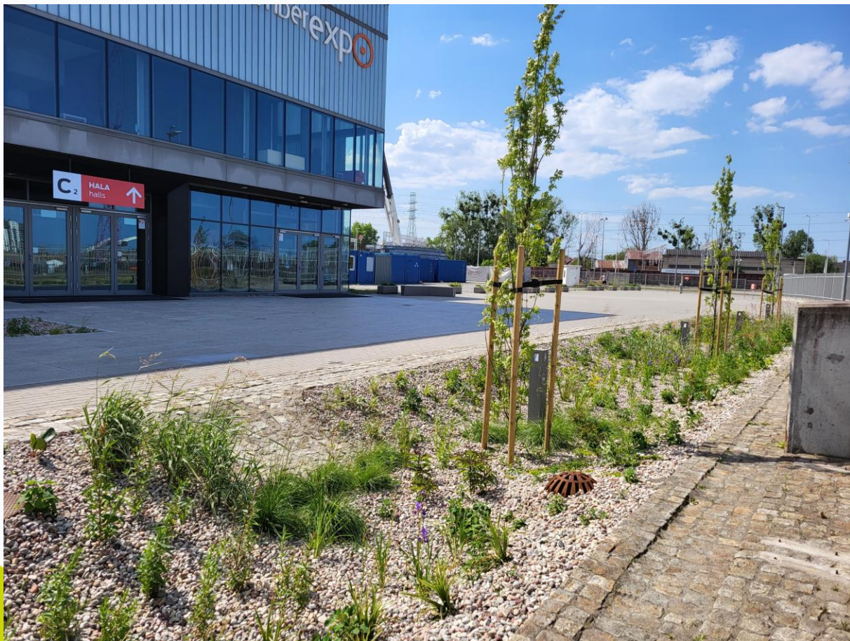
Ogród deszczowy – odbetonowanie nawierzchni
