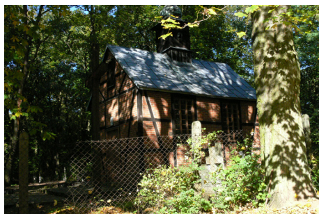
Ryc. 3. Malutka kaplica w miejscowości Barbarka pod Toruniem jest przykładem pokazującym, jak bardzo prosta budowla, wykonana w konstrukcji ryglowej z wypełnieniem ceglanym, mimo cieniutkich ścian znakomicie radzi sobie z „wygładzaniem” wahań klimatu zewnętrznego. Stabilizacji klimatu sprzyjają otaczające kaplicę drzewa
