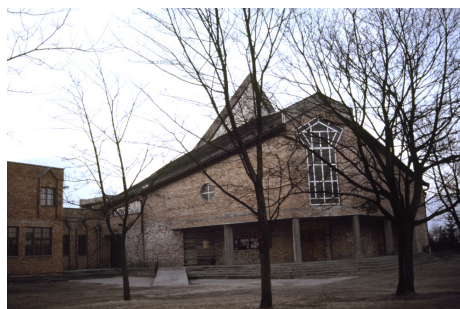
Ryc. 15. Czasem nawet nowe obiekty potrzebują pomocy. Fotografia kościoła budowanego od lat 80. Stan w marcu 2000 r.
