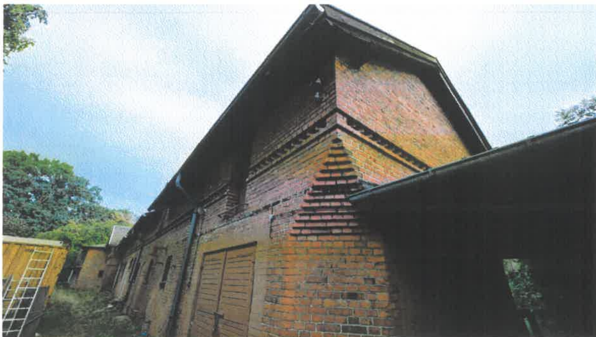
Budynek gospodarczy, elewacja północna, widok w kierunku południowym. Widać misternie wykształtowane sfazowanie z uskokami na narożniku budynku, a także rzeźbioną krokiew ściany szczytowej.
