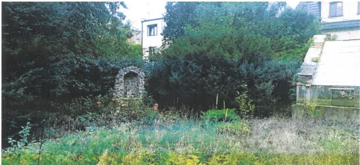
Widok na kapliczkę, po lewej fragment budynku szklarni.
