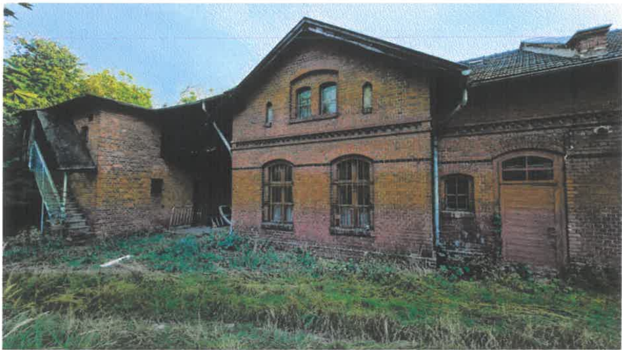
Budynek gospodarczy, elewacja północna, fragment w części wschodniej. Widoczna drewniana górna kondygnacja usytuowana nad przejazdem bramowym.
