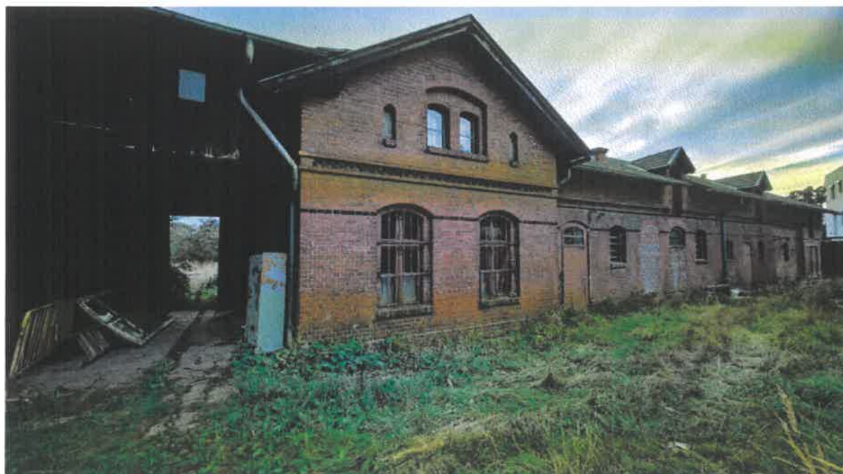
Budynek gospodarczy, elewacja północna, widok w kierunku południowo-zachodnim. Widoczna górna elewacja z charakterystycznymi szczytami. Wyraźnie widoczny fryz zębaty na całej długości ceglanej elewacji i poniżej pas z cegieł szkliwionych łączący łuki okien.
