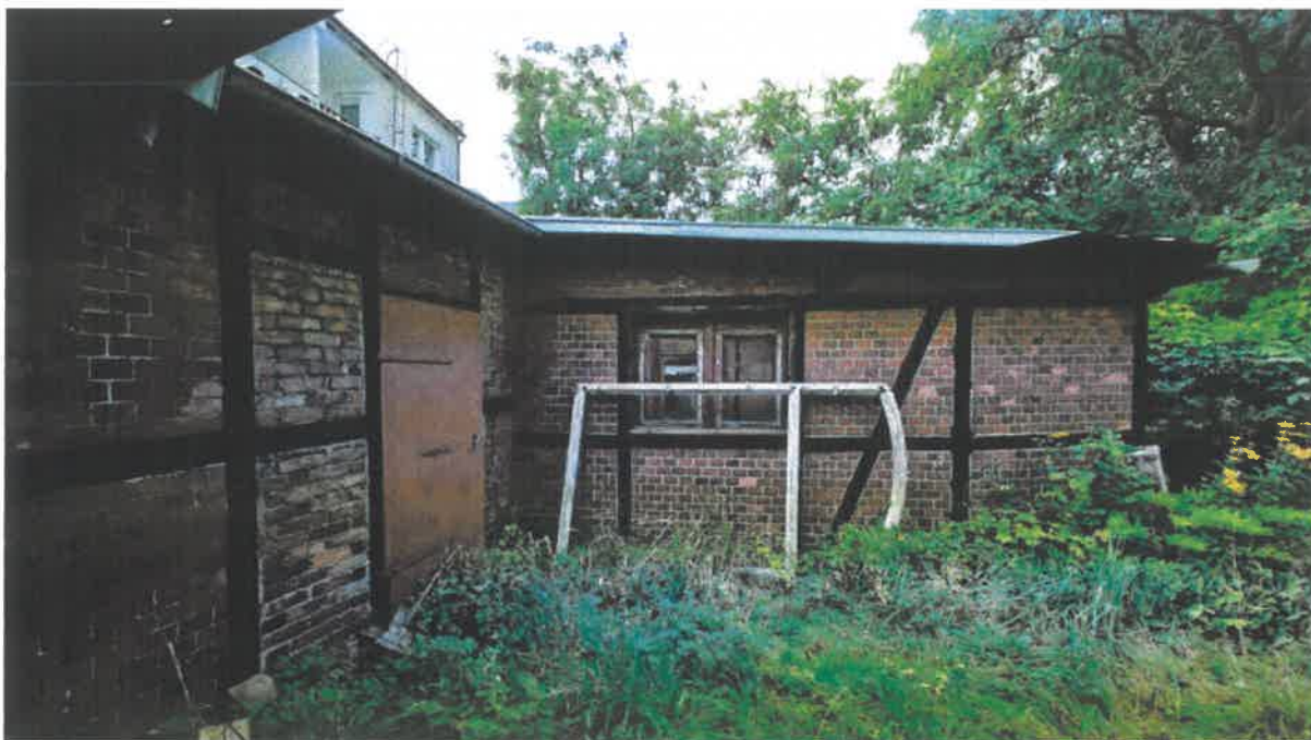
Widok aneksu przy budynku głównym zbudowanego w konstrukcji ryglowej.
